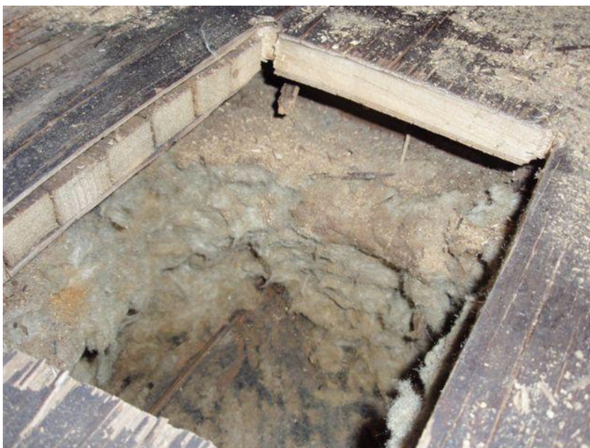
Kuva 26. Neljännessä tarkastusaukossa esiintyy kosteutta villoissa ja puussa (6).
