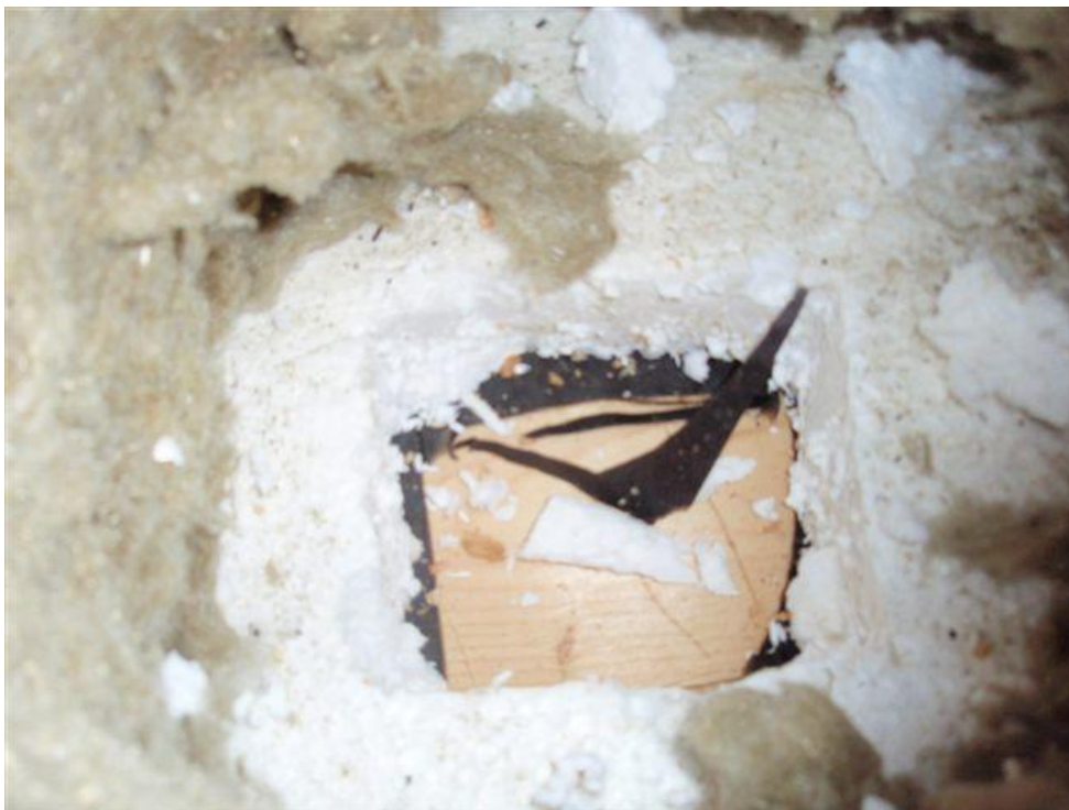
Kuva 23. Tarkastusaukon rakennekerrokset (6).
