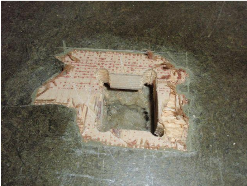
Kuva 28. Viidennessä tarkastusaukossa villa on kuiva ja puu on terve (6).
