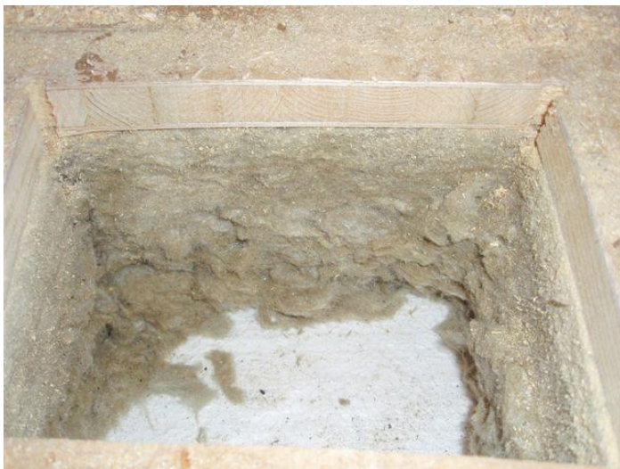
Kuva 21. Ensimmäisessä tarkastusaukossa villa on kuivaa ja puu tervettä (6).
