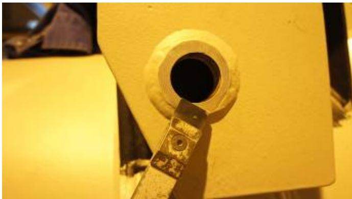
Kuva 65. Ylimääräinen maali poistetaan ohjaussylinterien ”haarukoiden” kiinnityspinnoilta.
