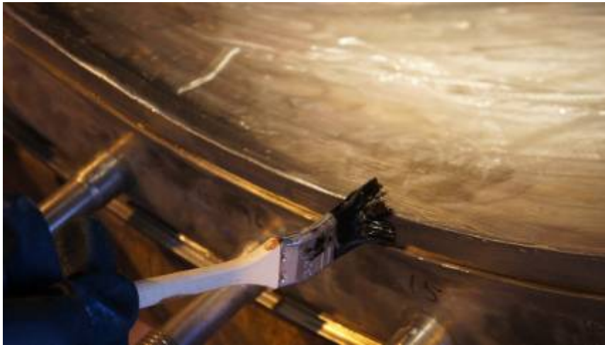
Kuva 77. Peittaustahnaa sivellään korjattuun pintaan.
