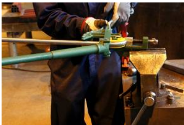
Kuva 112. Hydrauliputket muotoillaan putkivääntimellä. Putki on ulkohalkaisijaltaan 20 mm sekä seinämävahvuudeltaan 2,0 mm. Putken materiaali on ruostumaton teräs AISI 316 L.
