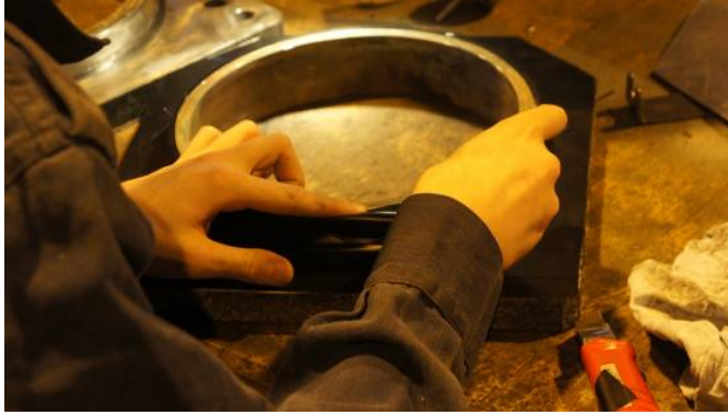
Kuva 47. Suunnanvaihtolaitteen laakeripesän sisäpintojen suojaus teipillä. Vanha laakeriholkki jätetään tässä vaiheessa vielä laakeripesään.
