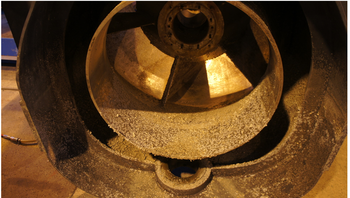
Kuva 11. Ohjaussiivistökammio merirokon peitossa pitkän seisontajakson jälkeen. Merikasvusto heikentää aluksen hydrodynaamisia ominaisuuksia ja täten hidastaa aluksen nopeutta sekä lisää polttoaineen kulutusta
