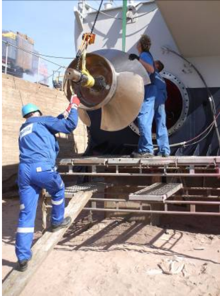
Kuva 130. Akselin ja impellerin asennus alukseen (kuva: merivoimat)
