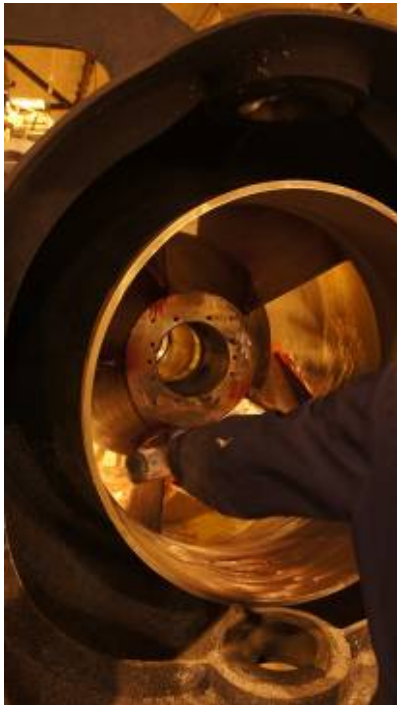
Kuva 43. Tunkeumaväriä suihkutetaan ohjaussiivistön saumakohtiin.
