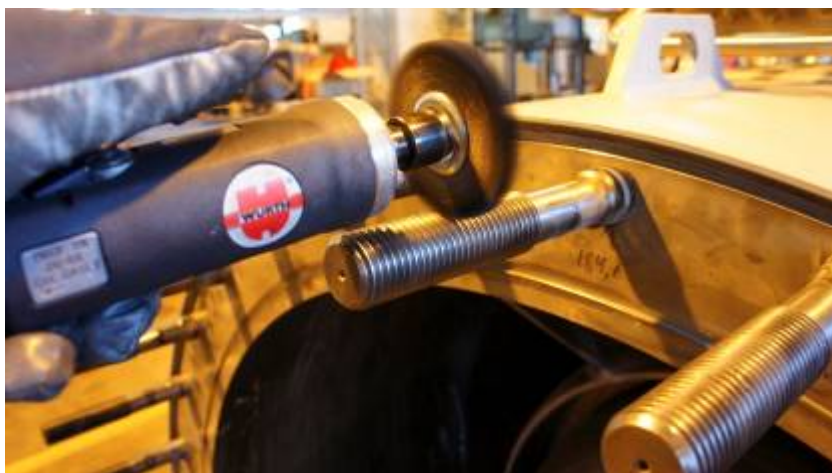
Kuva 57. Ohjaussiivistökammion pinnapulttien puhdistus pyörivällä ruostumattomalla teräsharjalla
