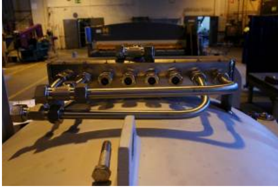
Kuva 113. Mitoitetut ja taivutellut hydraulikkaputket kiinnitellään jakotukin pääteliittimiin.
