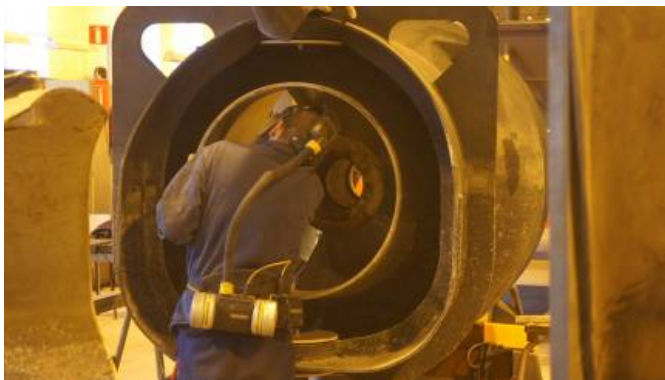
Kuva 41. Ohjaussiivistökammion puhdistyöt. Puhdistajan on käytettävä raitisilmasuodatinmaskia.
