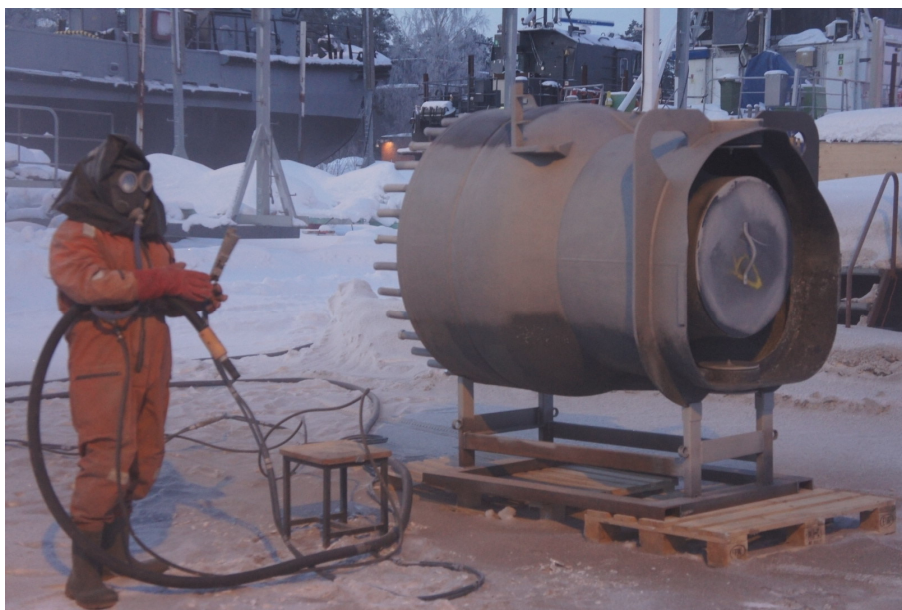
Kuva 13. Ohjaussiivistökammio hiekkapuhallettavana
