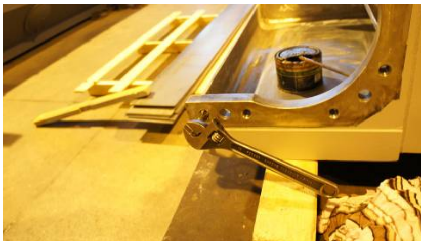
Kuva 56. Kierteet puhdistetaan M16- kierretapilla
