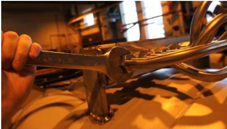
Kuva 118. Hydrauliiikkaputken kiinnitys jakotukkiin
