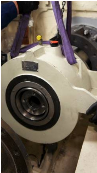
Kuva 132. Painelaakeriyksikkö asennetaan istukkaa vasten kuormaliinoilla.
