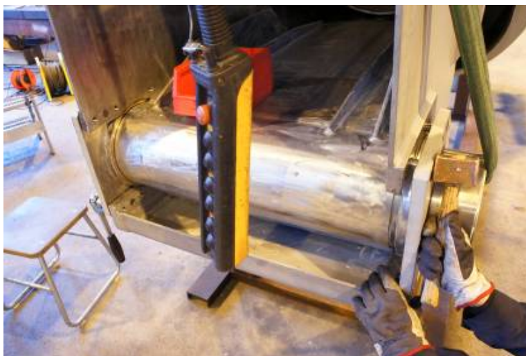
Kuva 90. Suunnanvaihtolaitteen laakeripesää asetellaan ohjuritappien kohdille kuparilekalla koputtelemalla. Lopuksi laakeripesä kiinnitetään M16-kuusiokolopulteilla.
