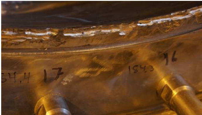
Kuva 73. Syöpyynyttä terästä on poistettu. Viilan jättämä railo korjaushitsataan umpeen.
