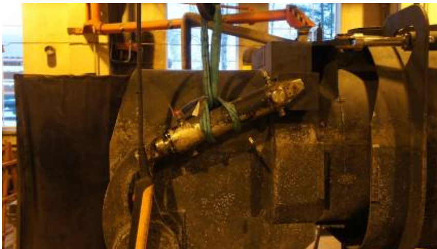
Kuva 5. Nostoliina on kierretty suunnanvaihtolaitteen ohjaussynterin ympärille ja kiinnitetty nosturiin. Tämän jälkeen ohjaussynteriä kannattelevat niveltapit voidaan irrottaa.
