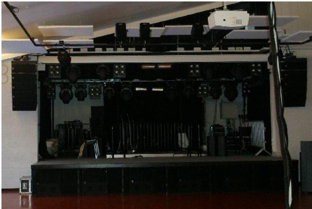
Kuva 46. Valmiin lavan tekniikkaa.
