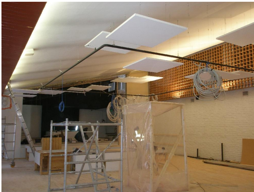
Kuva 44. Leijuvien akustiikkalevyjen asennus.
