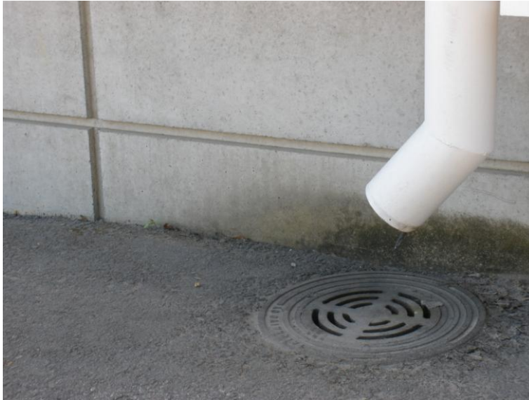
KUVA 3. Kaapeli roikkuu syöksytorven suulla (Kuva: Toni Sulonen 2011)
