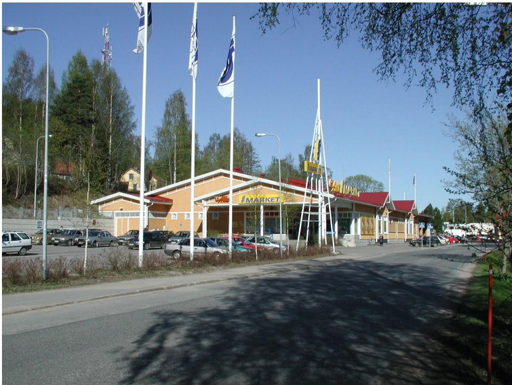
KUVA 1. Yleiskuva kiinteistöstä (Kuva: Pirkanmaan Osuuskauppa 1999)
