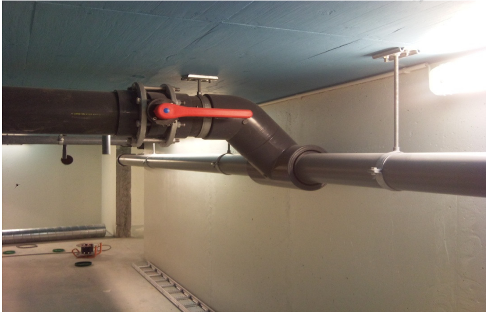
KUVIO 25. Venttiilin kiinnitys.
