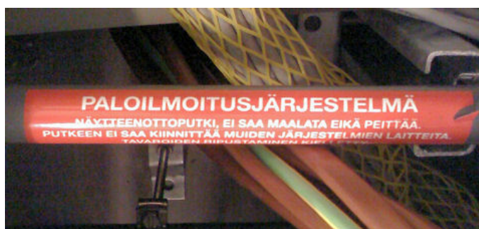
Kuva 4. Lattialaatan alapuolella oleva ilmaisinputki.
