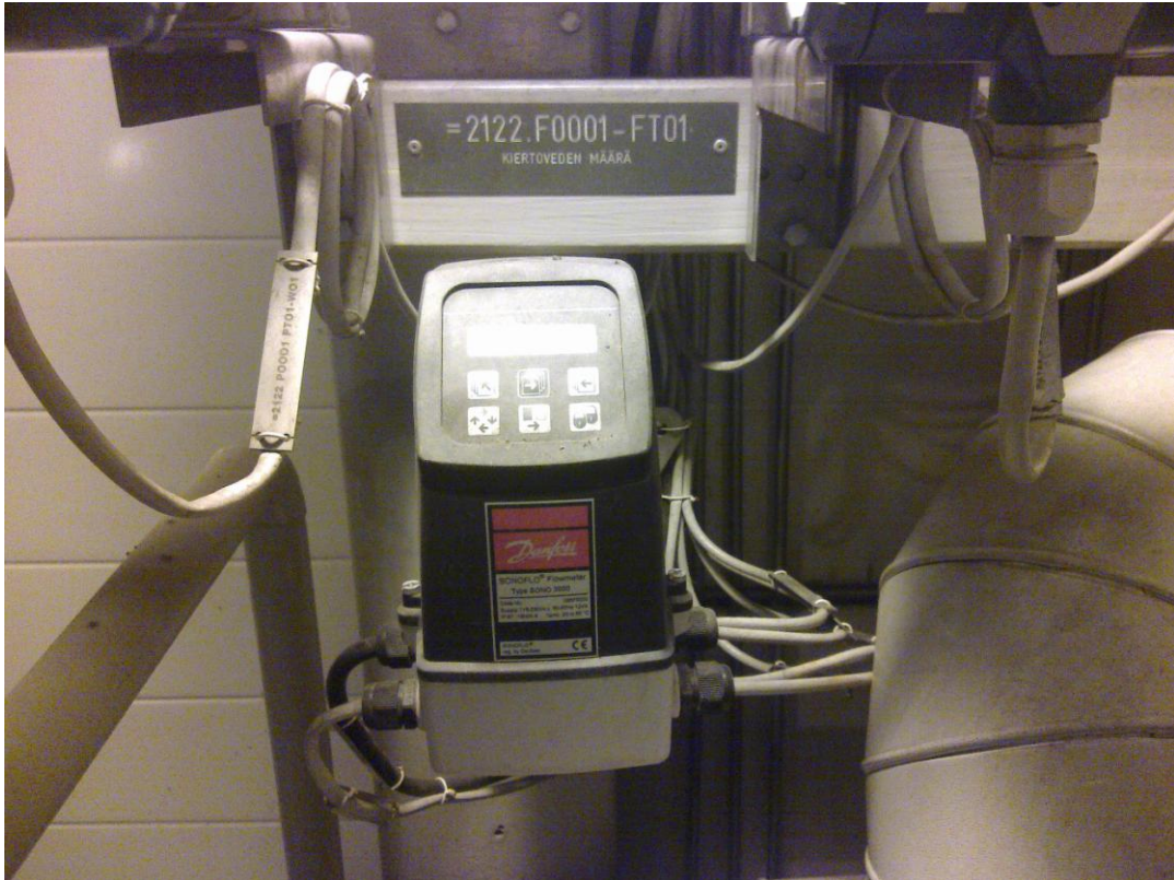
Kuva 9 Kiertoveden virtausmittaus
