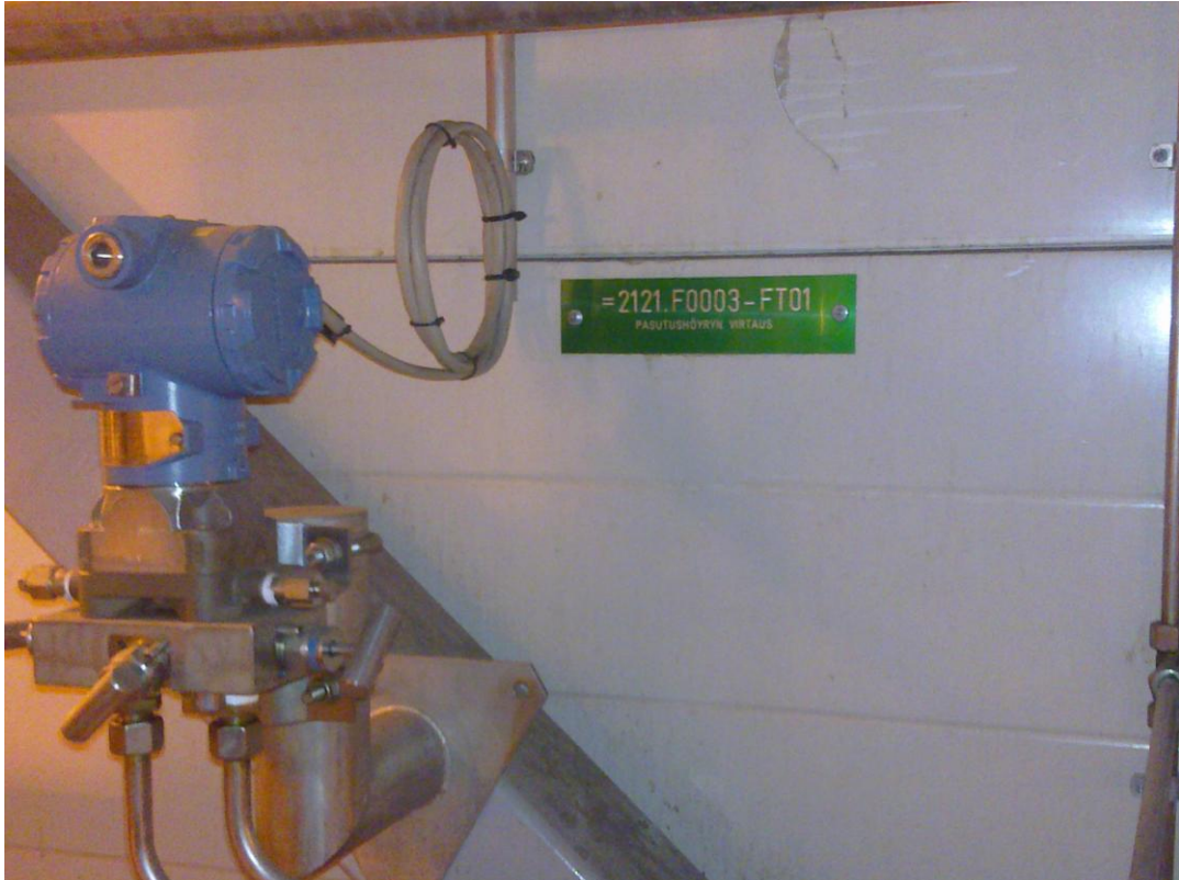
Kuva 3 Pasutushöyryn virtausmittaus
