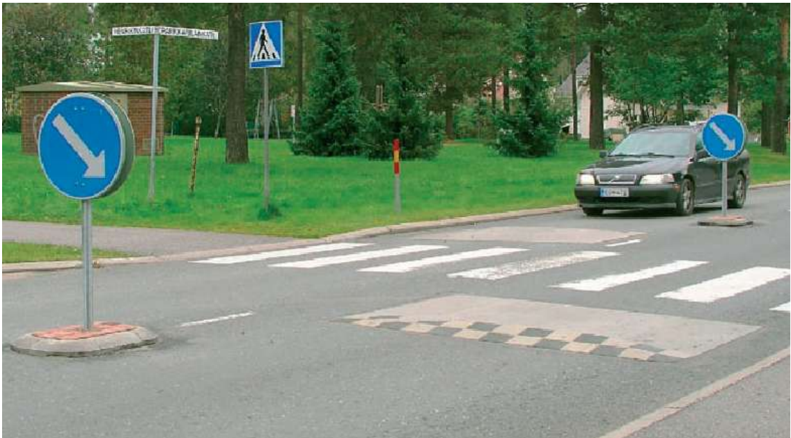
Kuva 8: Lohja Ruduksen betoninen hidastinelementti asennettuna. Liikennemerkkisäarekkeet estävät elementtien kiertämisen. (Kuva: Rudus liikennehidasteet 2009, 3.)
