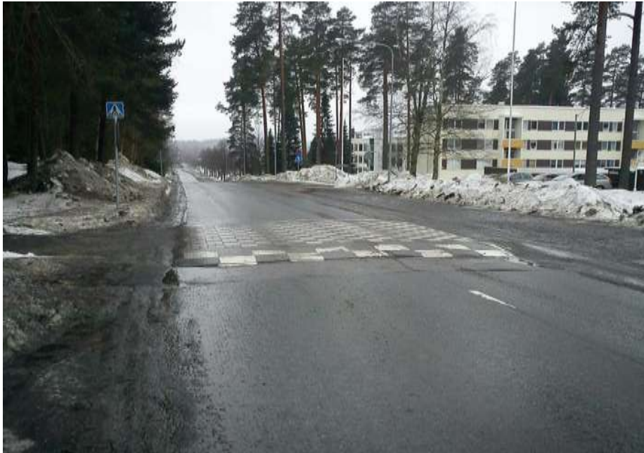
Kuva 6: Asfaltista rakennettu korotettu suojatie. (Kuva: Mikko Heikkilä).
