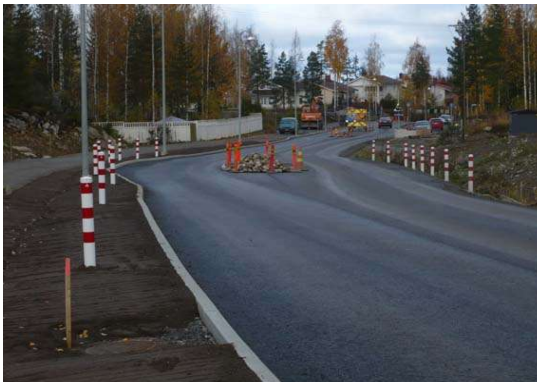
Kuva 20: Tien kuivatus on hoidettu vasemmalla kaistalla sadevesikaivolla ja oikealla puolella avo-ojalla. (Kuva: Mikko Heikkilä).
