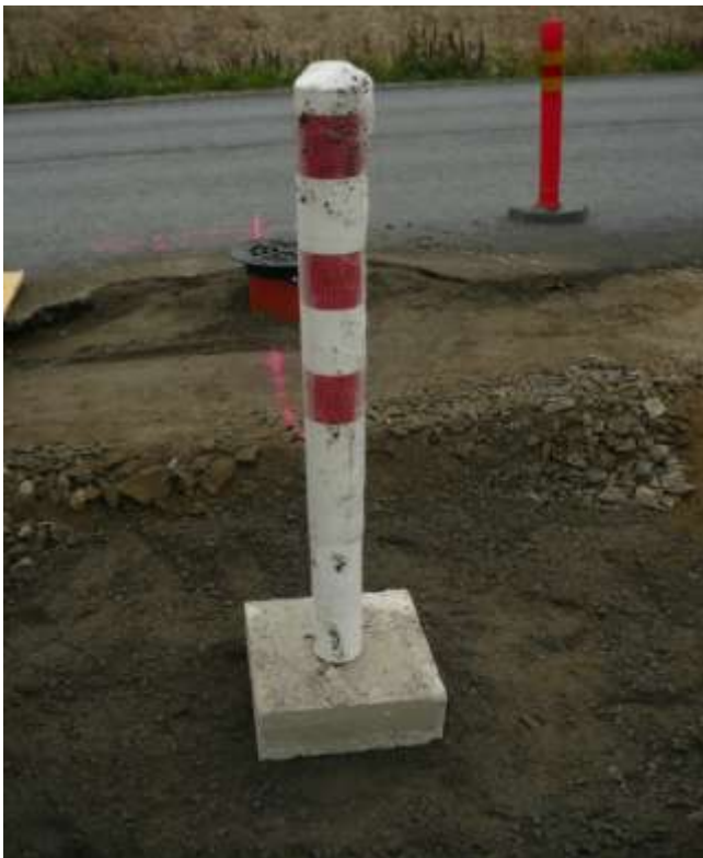
Kuva 26: Pollari asennuspaikassaan. Kiviaineksena tuli- si käyttää esim. Kam 0/8. (Kuva: Mikko Heikkilä).
