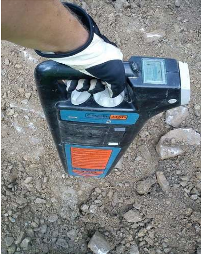
Kuva 29. Kaapelinhakulaitteen avulla voidaan selvittää kaapelien sijainti maan alta.
