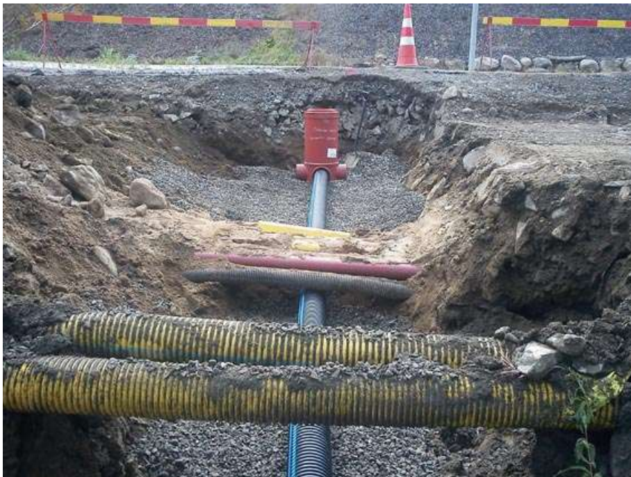
Kuva 28. Uuden sadevesikaivon asennus. (Kuva: Mikko Heikkilä).
