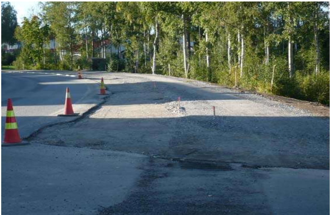
Kuva 17: Kurikantien ja Leppäsenkulman liittymään rakenteilla olevan keskisaarekkeen johdosta ajorataa oli levennettävä 2 m. Uusi linja on merkitty mittamerkeillä. (Kuva: Mikko Heikkilä).
