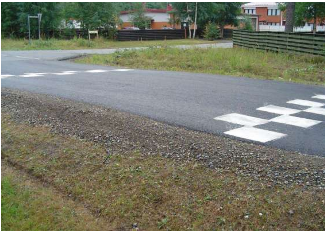
Kuva 13: Valmis sinikaaritöyssi mitoitusnopeudeltaan 50 km/h. (Kuva: Lauri Koponen 2006a).
