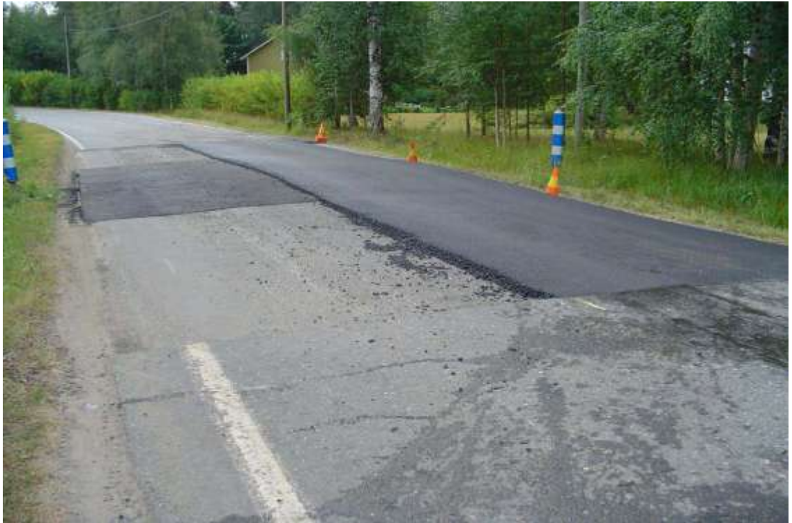
Kuva 12: Päällystemassasta rakenteilla oleva sinitöyssi. (Kuva: Lauri Koponen 2006a).
