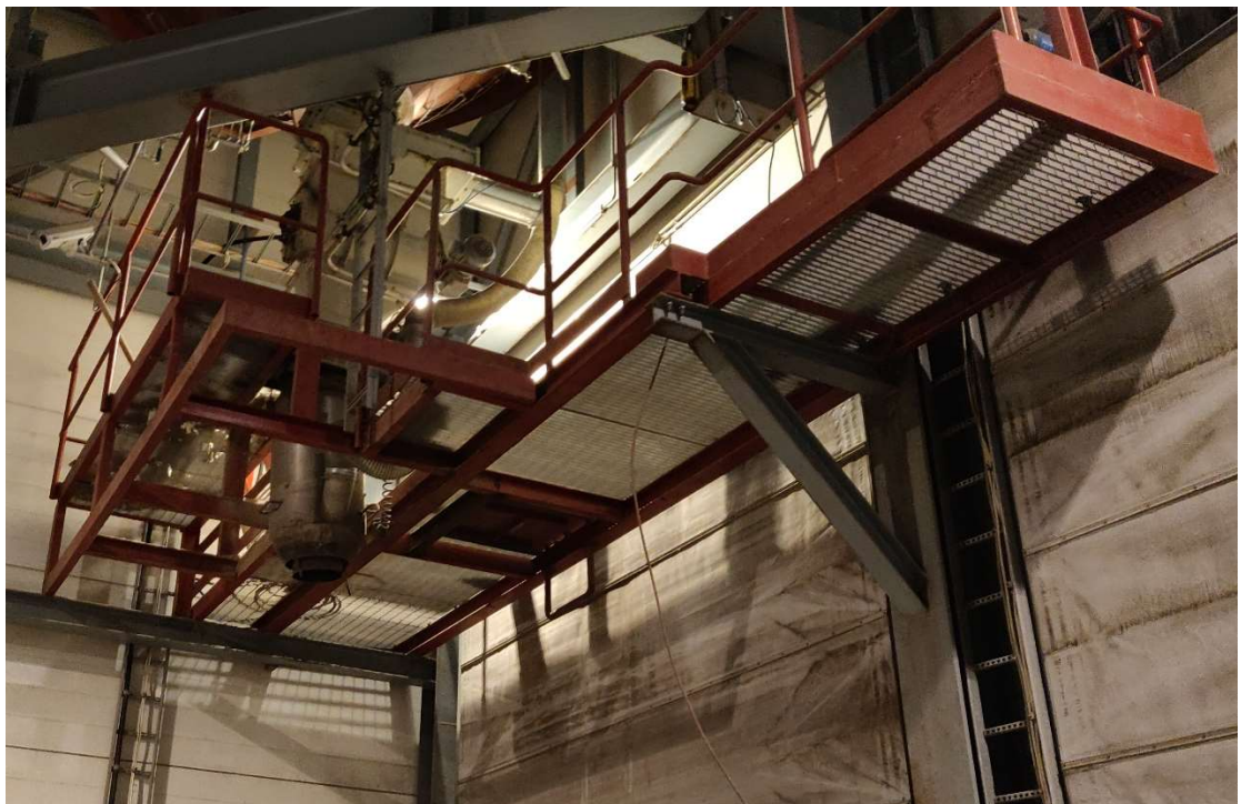
Kuva 8. Tuhkansiilon alla oleva purkaustaso
