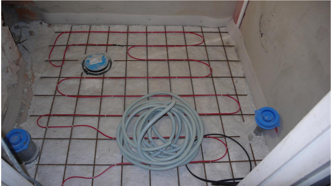
Kuva 3. Työn alla oleva kylpyhuone perinteisessä linjasaneerauksessa.
