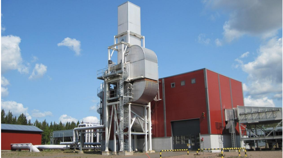
Kuva 6. Valkeala B kompressoriasema ulkoa kuvattuna. Etualalla näkyy pakokaasujen lämmöntalteenottoyksikkö, (Omat valokuvat 16.06.2011)
