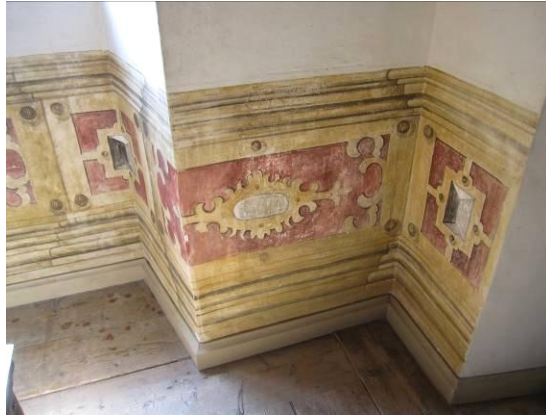
Kuva 13. Louhisaassa herrainkamarin 1660-luvun kalkkimaalattu seinä. Seinäpaneeli on maalattu secco-tekniikalla.
