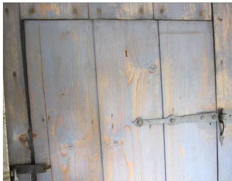
Kuva 5. Läpikuultava öljymaalikerros komeron ovesa. Asunto nro. 174 Luostarinmäellä.
