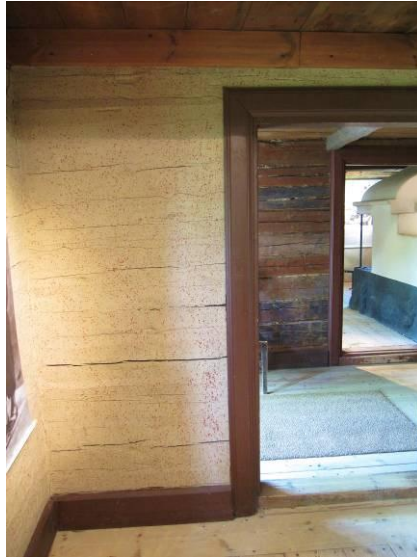
Kuva 4. Laudankantajan asunto nro. 160 Luostarinmäen käsityöläismuseossa. Kuvan roiskemaalaus on tehty suoraan hirsiseinään.
