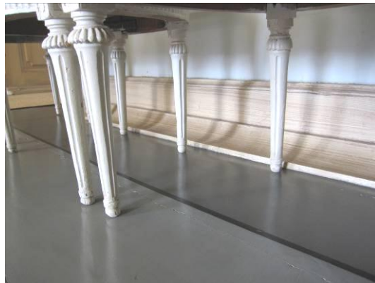
Kuva 9. Louhisaaren ison salongin lankkulattia on maalattu pellavaöljymaaleilla.
