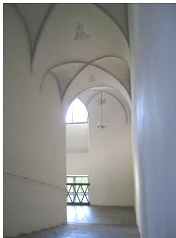
Kuva 12. Valkoista kalkkimaalipintaa Louhisaarella.
