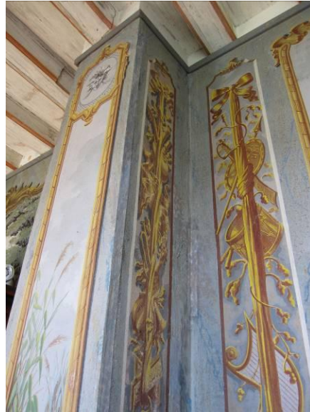
Kuva 6. Pirun kamari Louhisaassa. Seinällä on sidokseltaan kahta erilaista kangasta, jotka on maalattu pellavaöljymaalein. Palkin päässä oleva satyyrin pää ja sen taustakuvio viittaavat 1700-luvun loppuun ja kustavilaiseen aikaan. (Lounatvuori & Knapas 2005, 122.)
