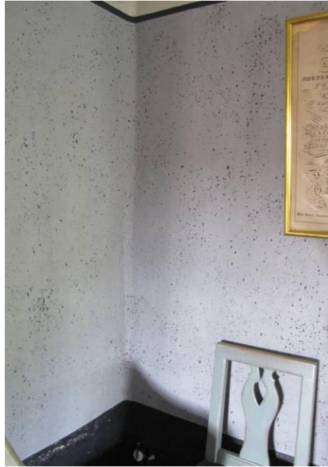
Kuva 11. Muurarin asunto nro. 171 ½ Luostarinmäellä. Huoneen seinät on rapattu ja roiskemaalattu liimamaalilla kahdella sävyllä keväällä 1940.
