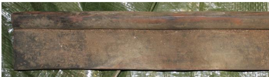
Kuva 23. Kumitiivisteiden pinta ennen puhdistusta (Mäkinen 2020)
