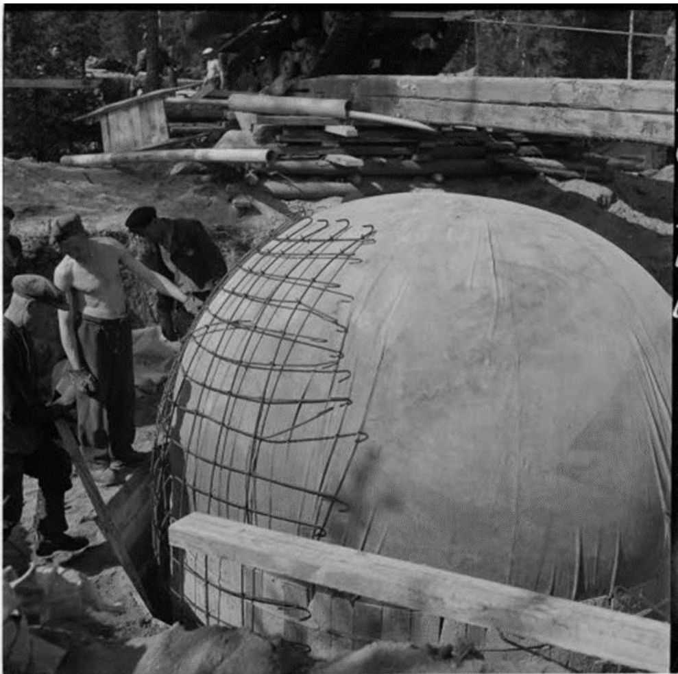
Kuva 6. Pallokorsun raudoitustyö meneillään (SA-kuva 1944)
