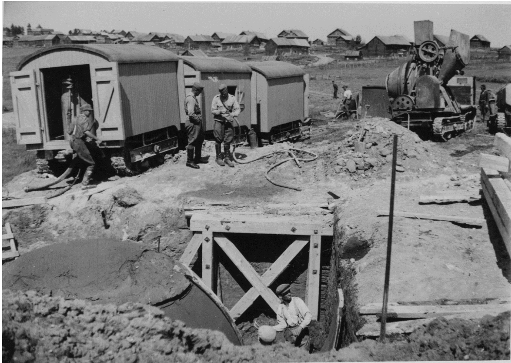
Kuva 5. Valutyömaa Sammatuksessa (SA-kuva s.a.)
