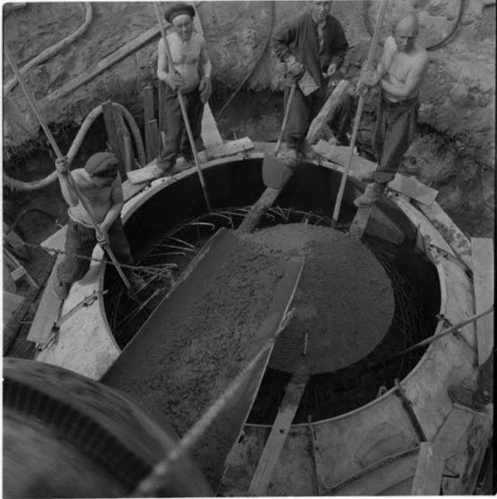
Kuva 7. Valukartion käyttöä (SA-kuva 1944)
