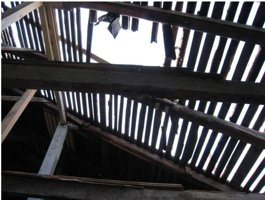
KUVIO 1. Ruodelaudoitukset olivat niin huonokuntoiset että työntekijä putosi ruodelaudoituksen läpi.
