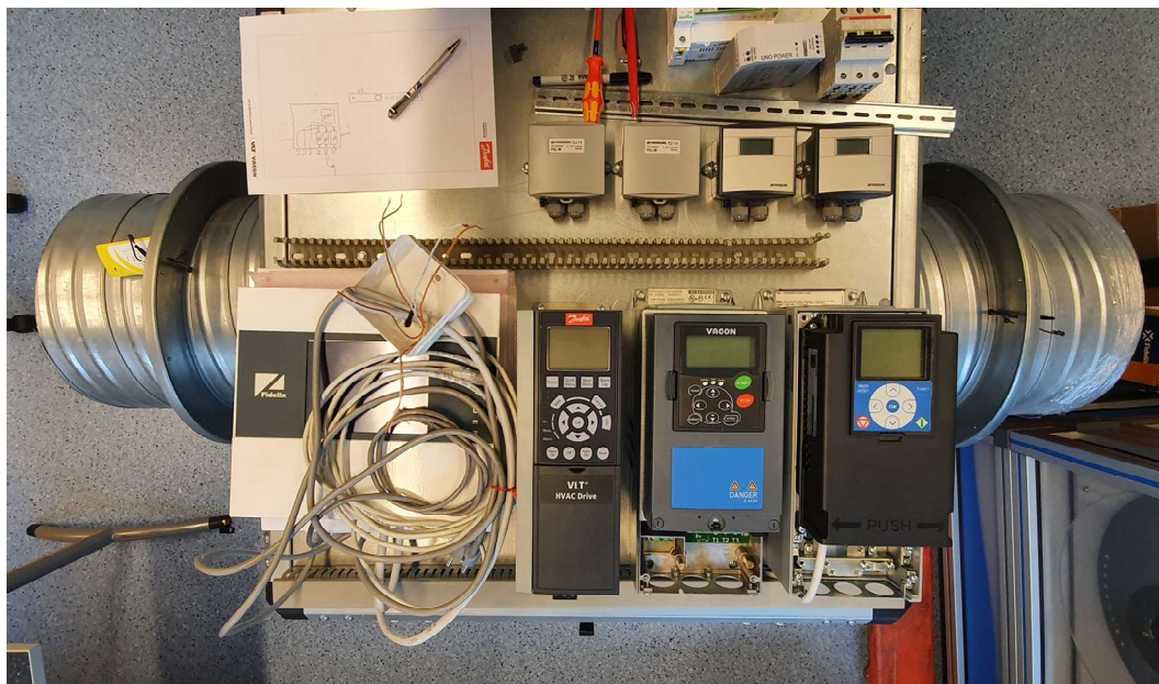
Kuva 16. Komponentit asennettuna paikoilleen.
