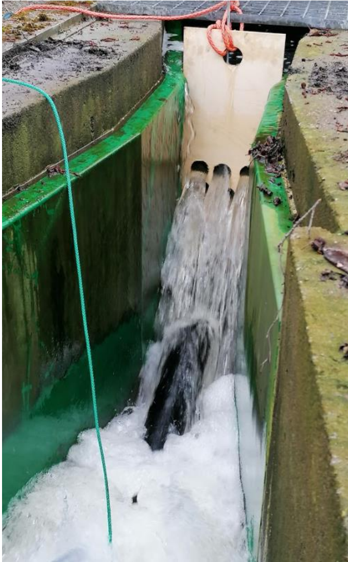
Kuva 18. Oxtube ja patolevy asennettuna jäteveden poistokouruun 13.3.2020.
