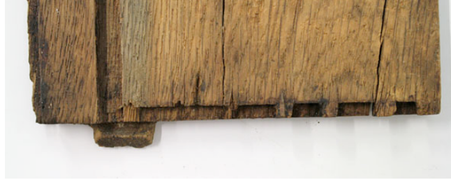
Kuva 4. Takasarjan hajonneet sinkkaliitokset, sekä pieni osa jäljelle jääneestä hajonneesta urasta, joka ohjaa ylösnostettavaa oikean sivustan päätyä. Valokuvaaja Mikko Iivonen
