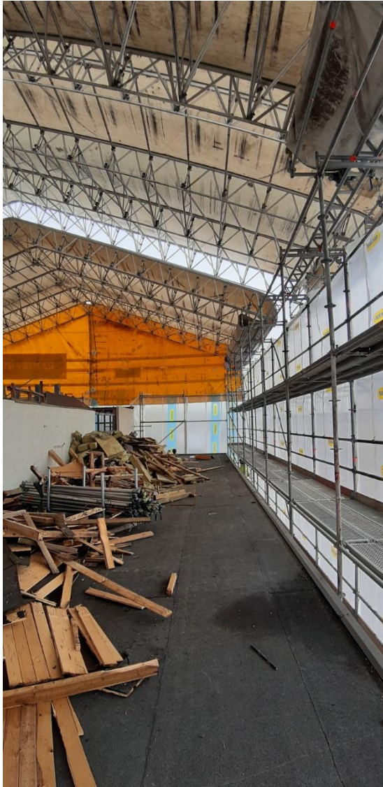
Kuva 3. Kajaanin virastotalon työmaa
