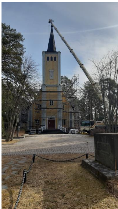
Kuva 2. Muhoksen kirkon työmaa
