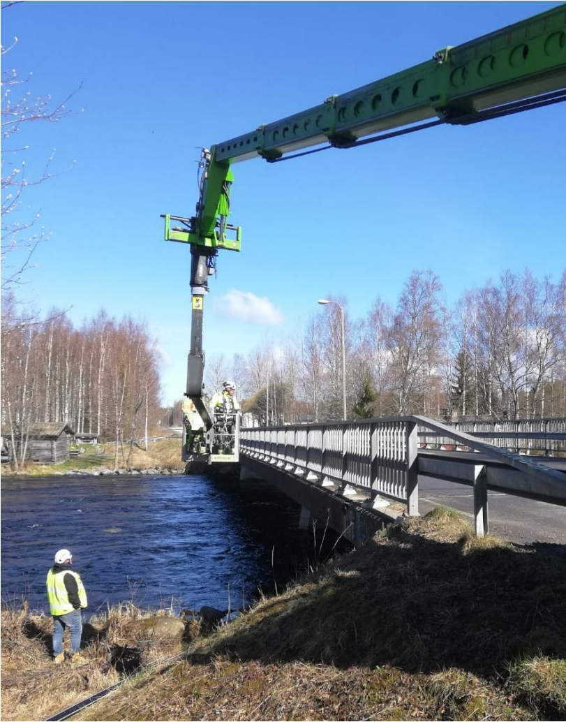
KUVA 12. Henkilönosto siltakiinnitystä varten (KNK Networks, 2020)
