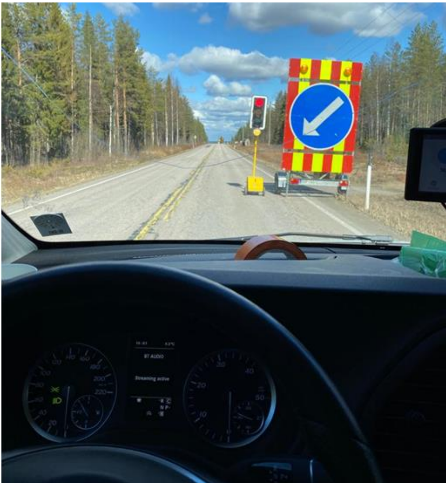
KUVA 8. Työnaikainen liikennevalo-ohjaus (Niskakoski, kuva-arkisto)
