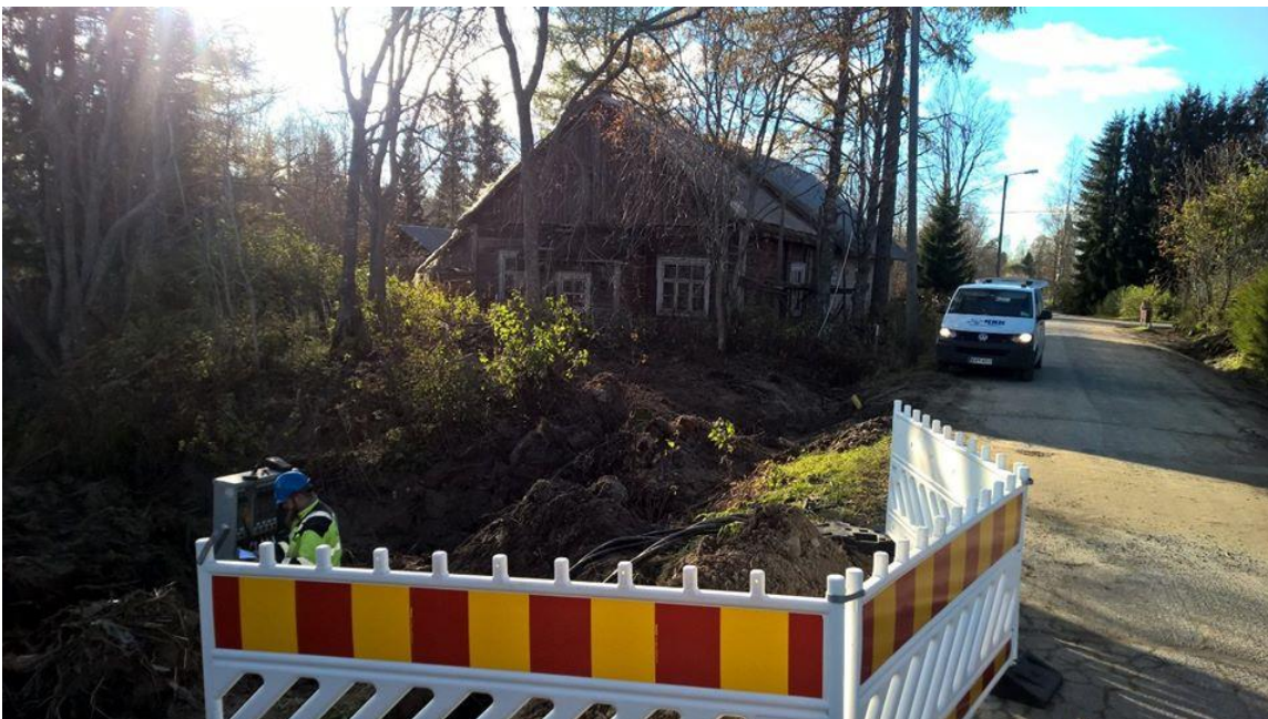
KUVA 18. Kaivannon suojaus kevytsuoja-aidoin (KNK Networks, facebook -galleria)
