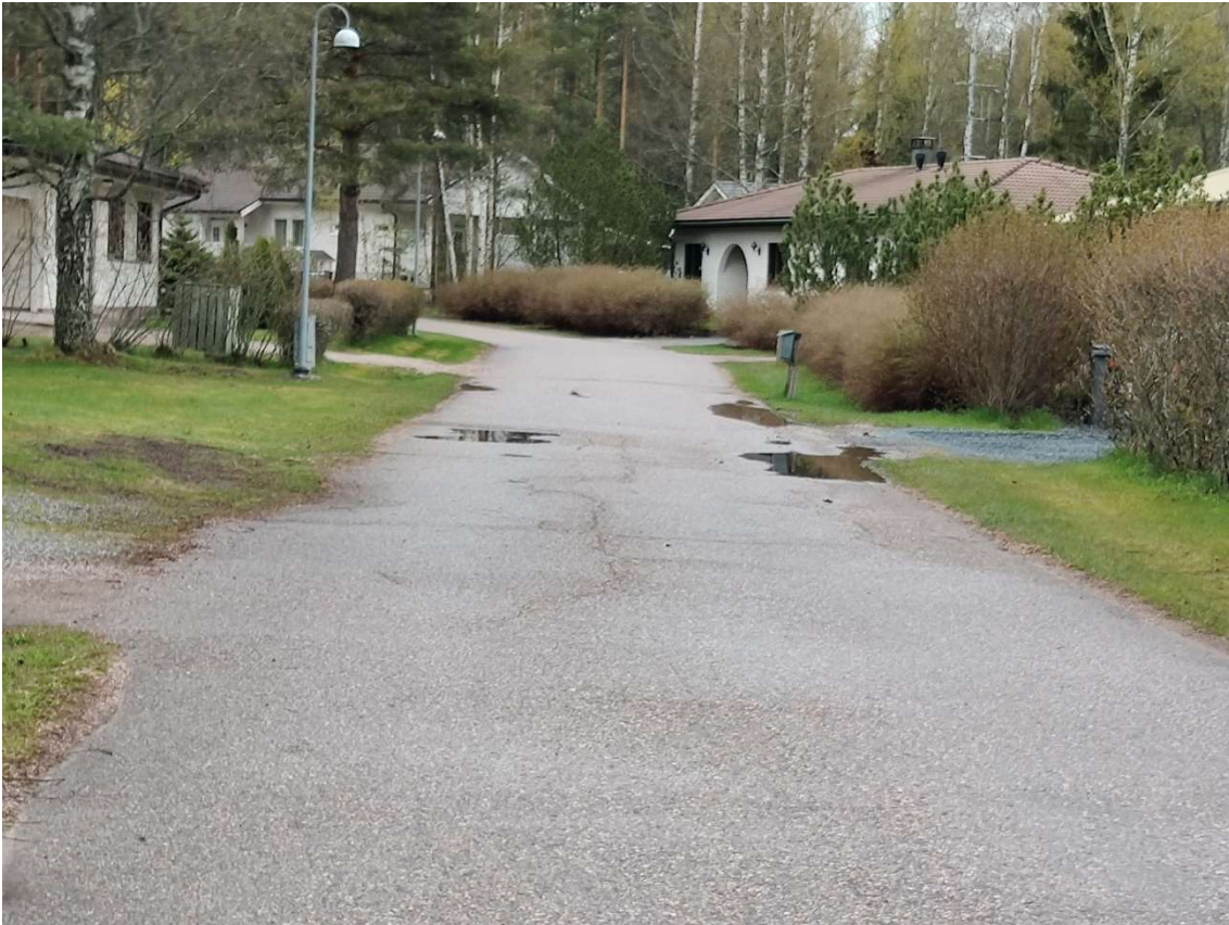
Kuva 65 Perunakuopantien epätasaisuuksiin kertynyt vettä sateen jäljiltä
