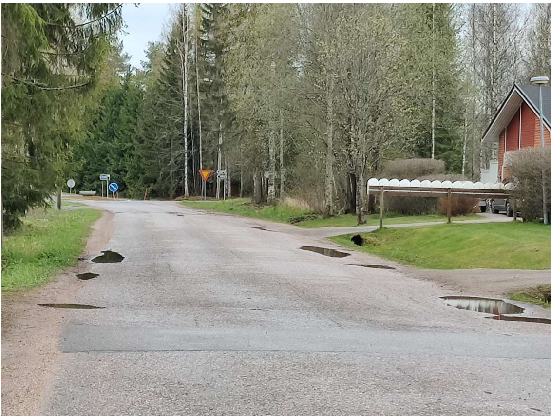
Kuva 63 Vangonojantien epätasaisuuksiin kertynyt vettä kevyen vesisateen jäljiltä
