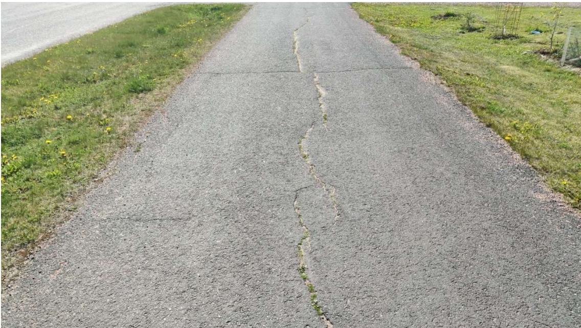
Kuva 34 Pitkittäishalkeama Eteläkaaren JK/PP:llä
