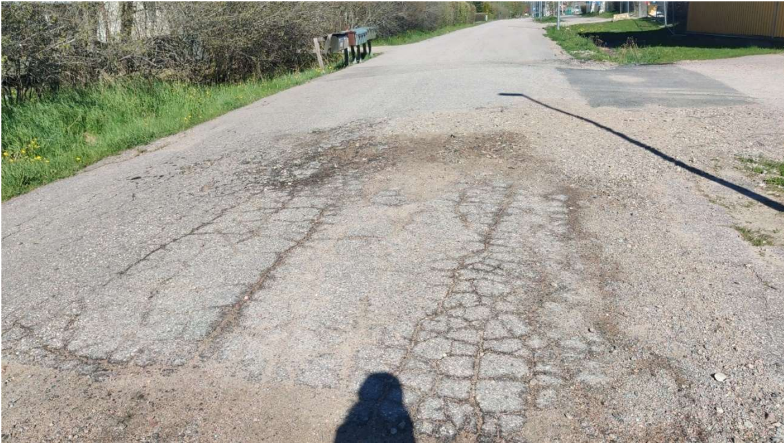
Kuva 21 Reikä ja halkeamia Koulutiellä
