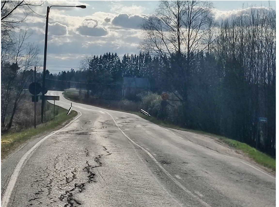
Kuva 8 Halkeamia ja epätasaisuutta Ohikulkutiellä
