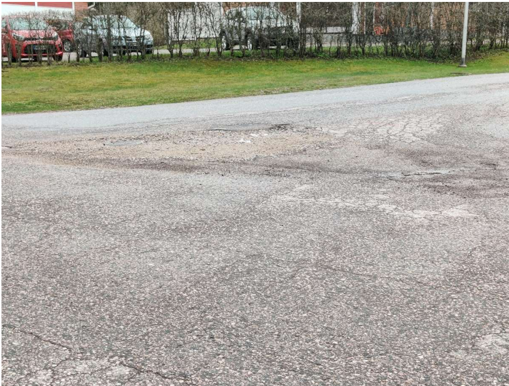
Kuva 62 Reikä Vangonojantien päällysteessä
