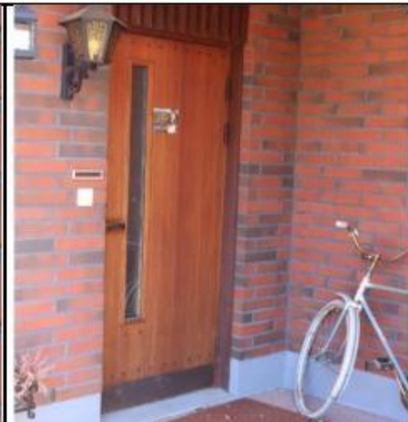
17. Pääsisäänkäynti suojassa katoksen alla.
