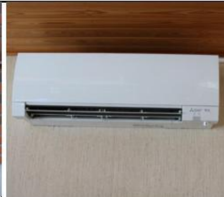
58. Ilmalämpöpumpun puhallin.
