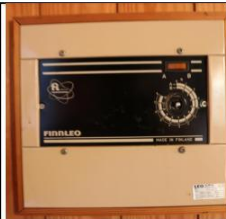
36. Rikkinäinen kiukaan säätökytkin.
