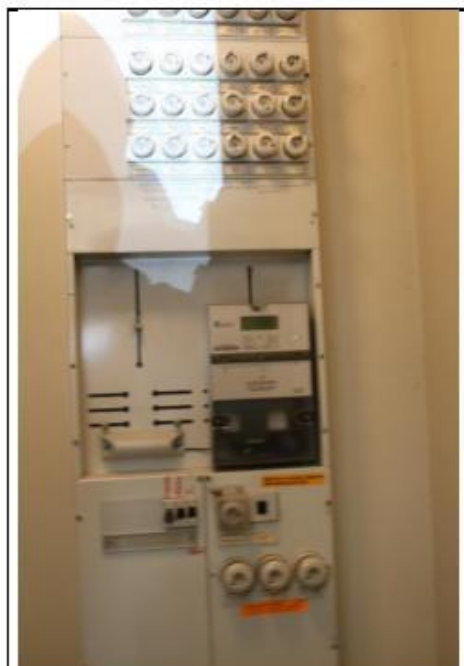
64. Sähkömittari ja sulaketaulu.
