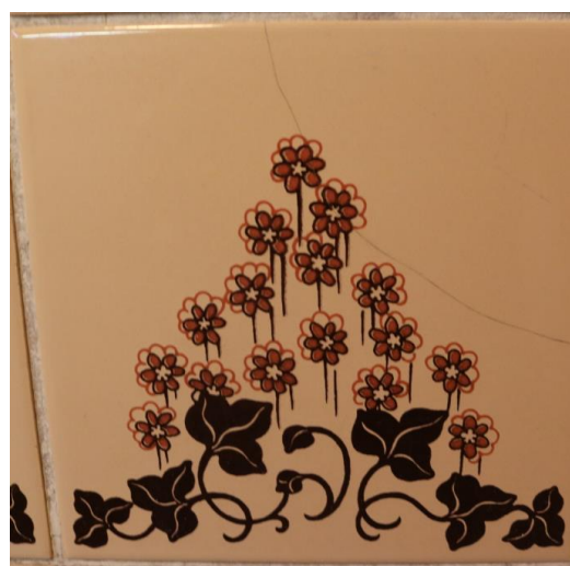
Kuva 20. Haljennut laatta.
