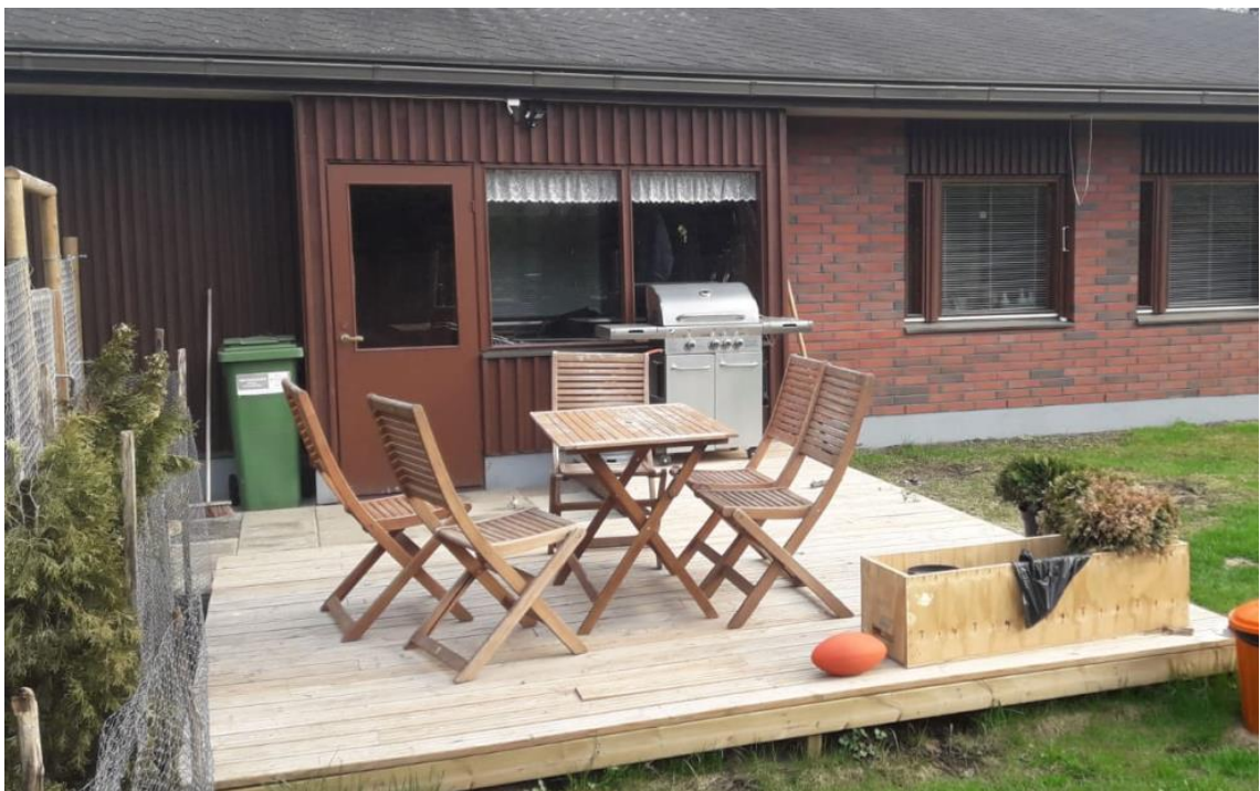
Kuva 14. Takapihan julkisivu ja terassi.
