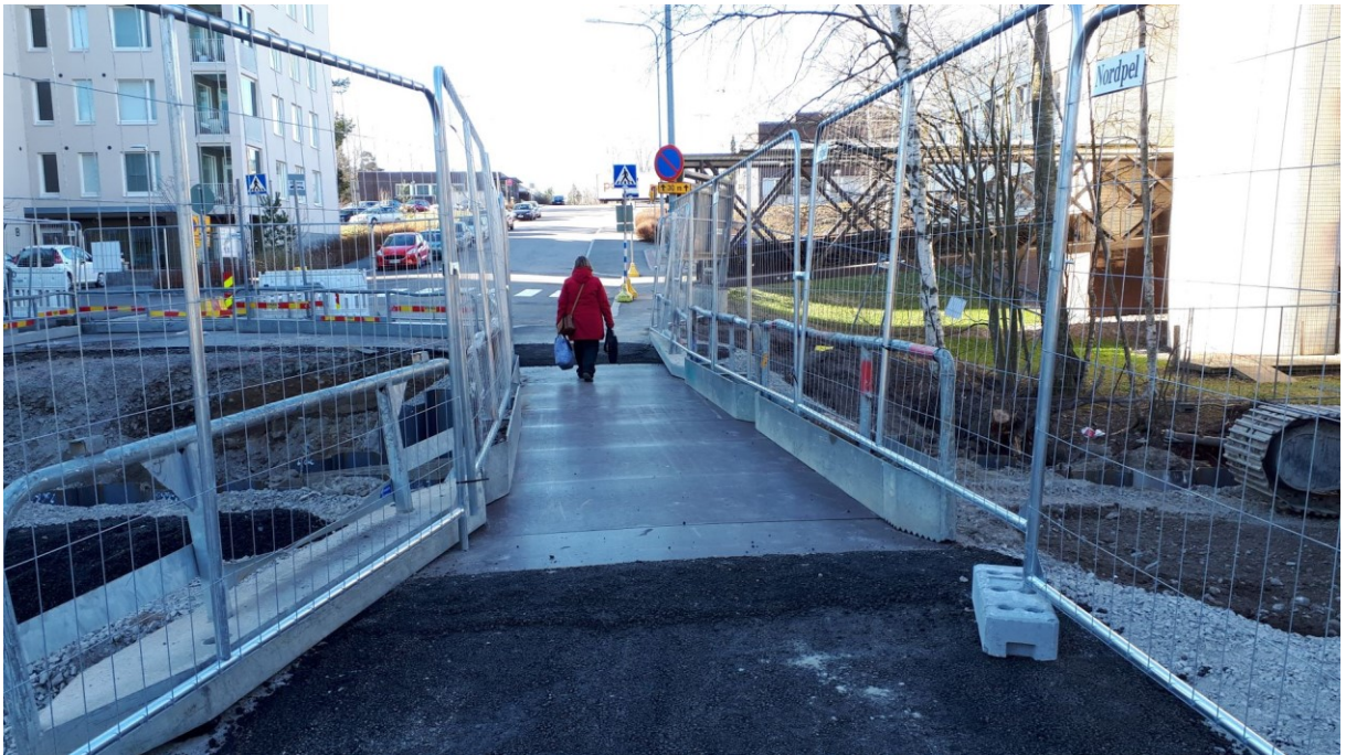
Kuva 21. Jalankulun ohjaus kaivantojen läheisyydessä (Roimela, 2020).
