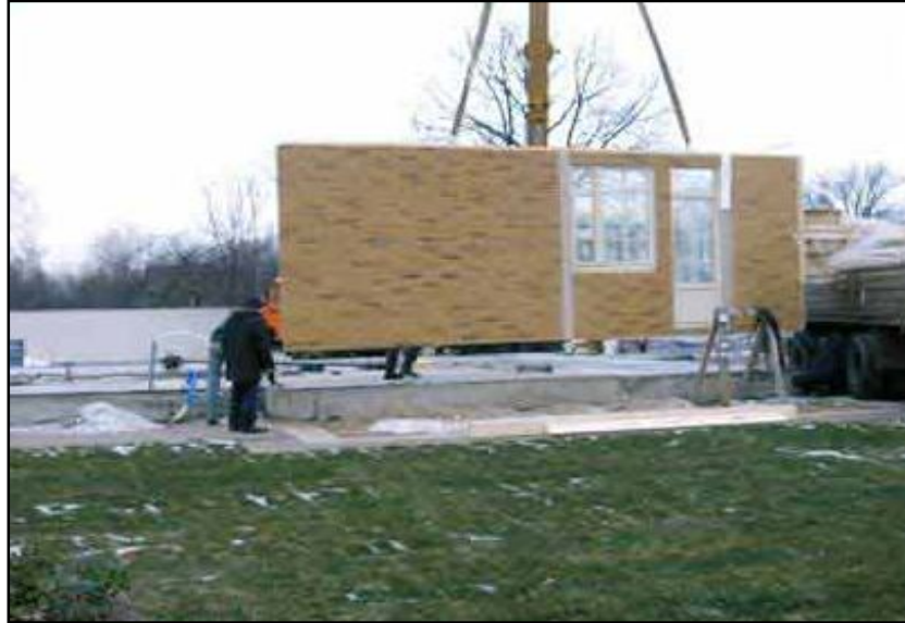
Kuva 20. Elementtien pystytys työmaalla
