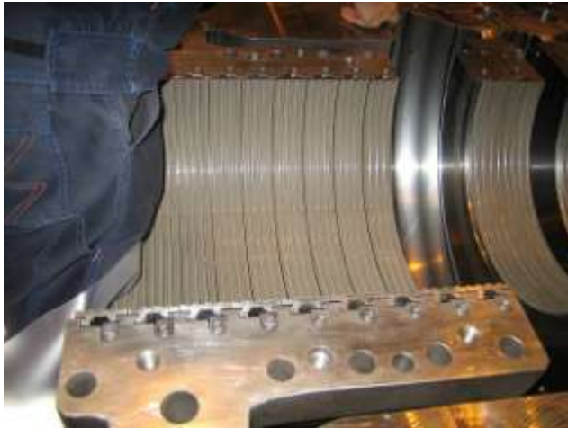
Kuva 12. Turbiinin tiivisterenkaat paikoilleen asennettuna/9/
