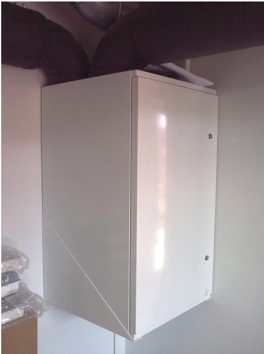
KUVA 23. Yleistilojen ilmanvaihtokone.
