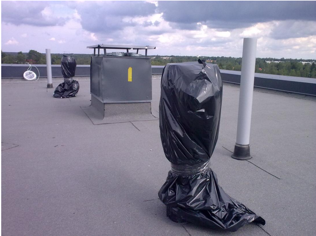
KUVA 21. Jätesäkeillä suljetut poistoilmakanavat rakennuksen katolla.
