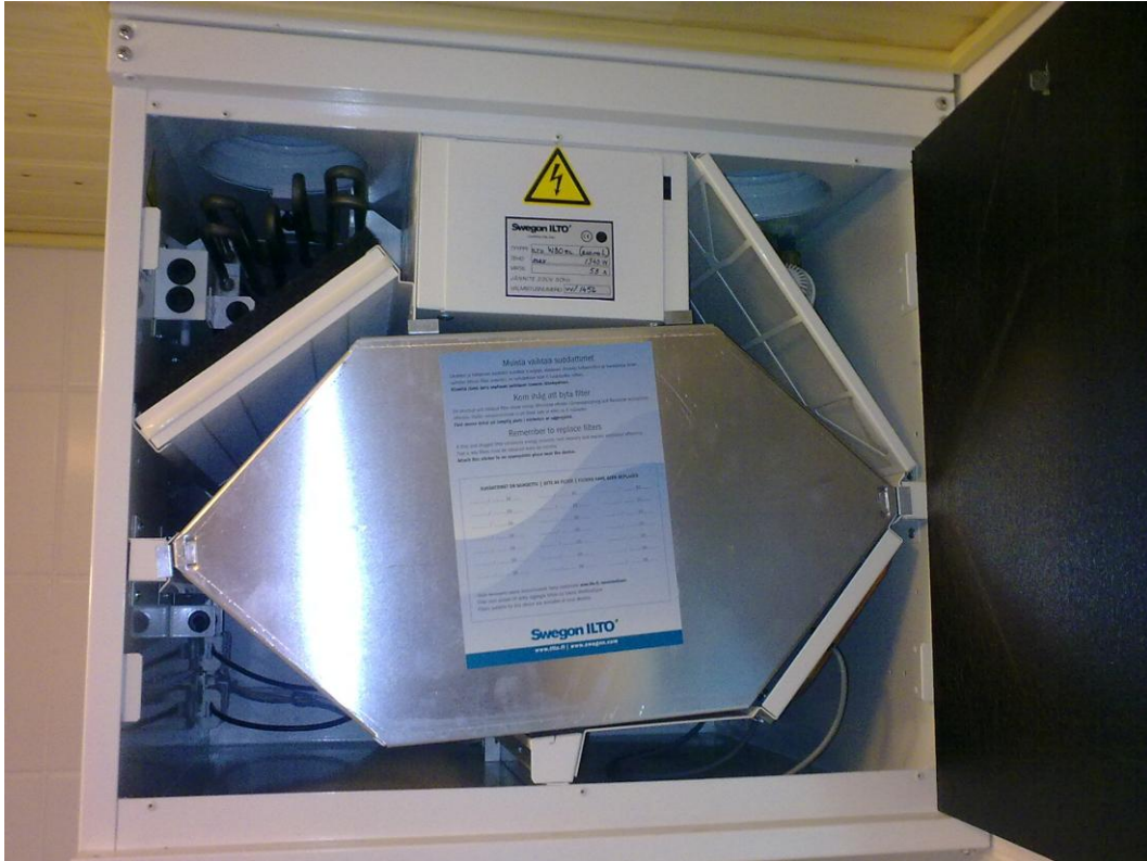
KUVA 7. Huoneiston ilmanvaihtokone.
