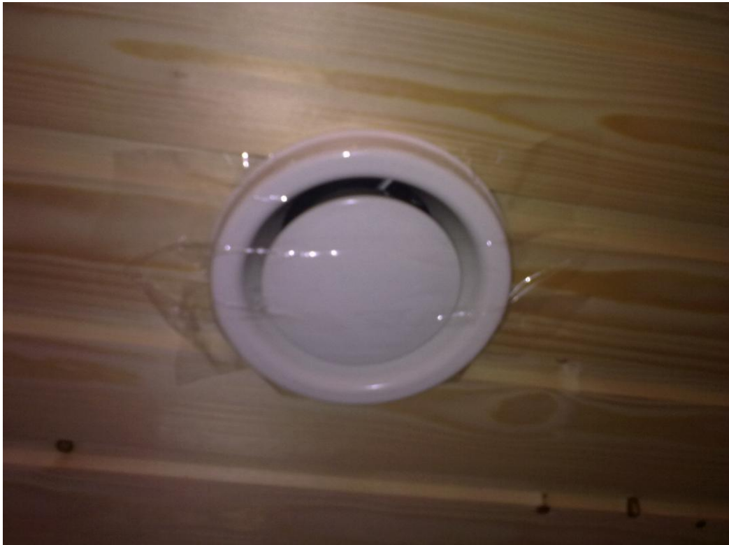
KUVA 18. Teipattu poistoilmaventtiili.
