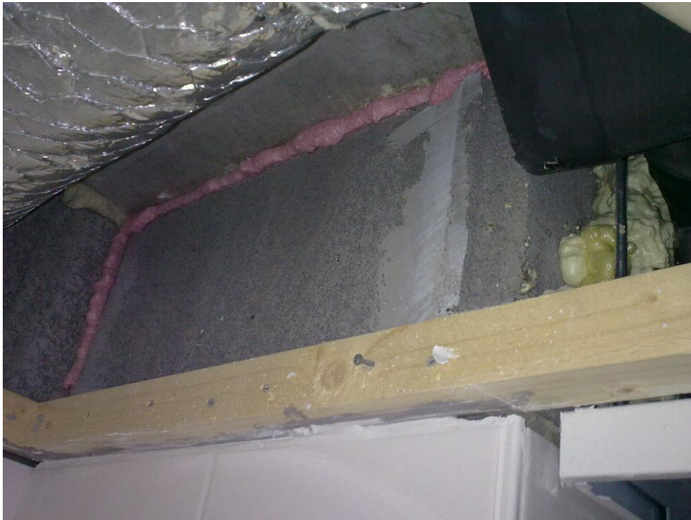
KUVA 12. Liitoksia tiivistettiin mm. uretaanivaahdolla.
