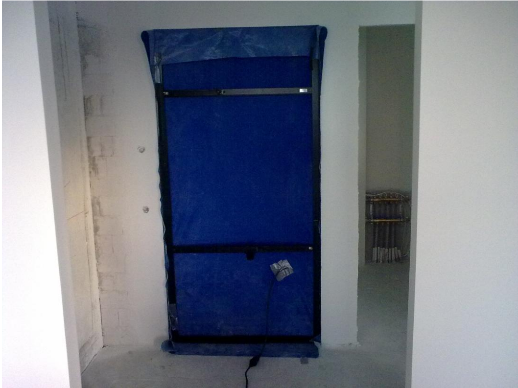
KUVA 6. Huoneiston rappukäytäväoven tiivistäminen.
