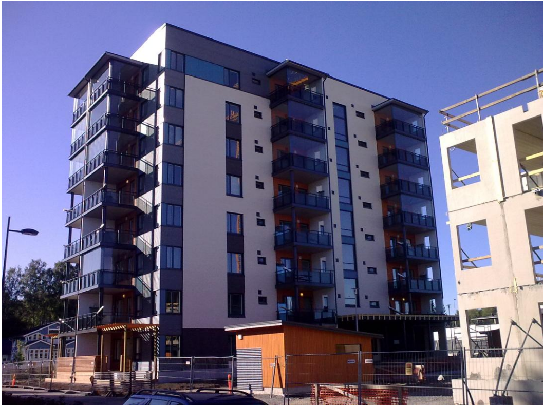
KUVA 3. Kohdetalo, Kiinteistö OY Vaasan Kustaanportti elokuussa 2010.
