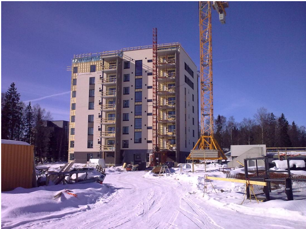
KUVA 2. Kohdetalo, Kiinteistö OY Vaasan Kustaanportti maaliskuussa 2010.
