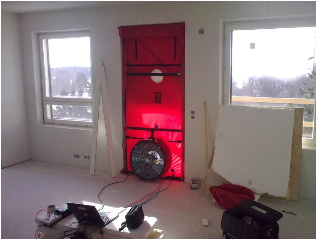
KUVA 15. Minneapolis BlowerDoor-laitteisto asennettuna huoneiston parveke oveen.
