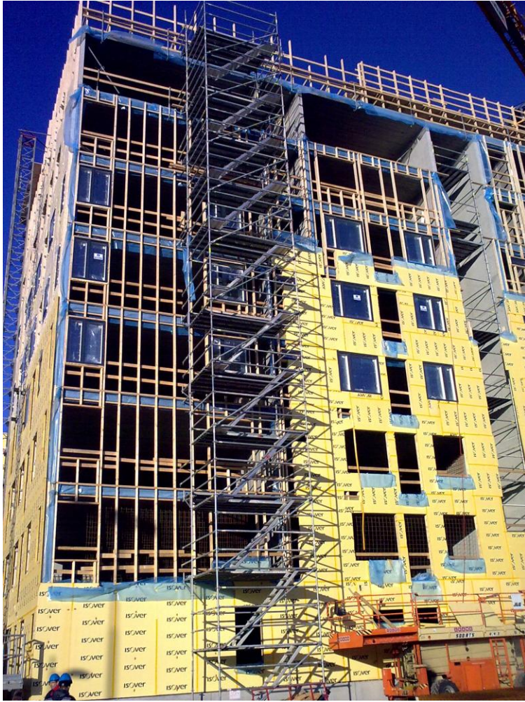
KUVA 1. Puurunkoisen seinän höyrynsulku asennettiin katkeamattomana läpi julkisivun. Liitokset teipattiin huolellisesti. Lokakuu 2009.
