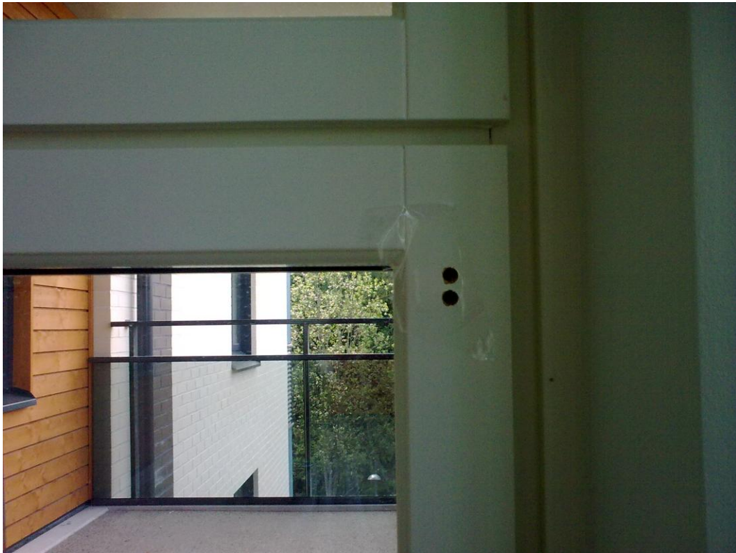
KUVA 20. Sälekaihtimia varten poratut reiät teipattiin umpeen.
