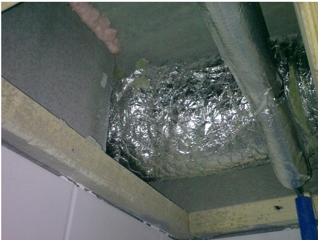
KUVA 8. Poistoilmaputken läpivienti pystyhormiin.
