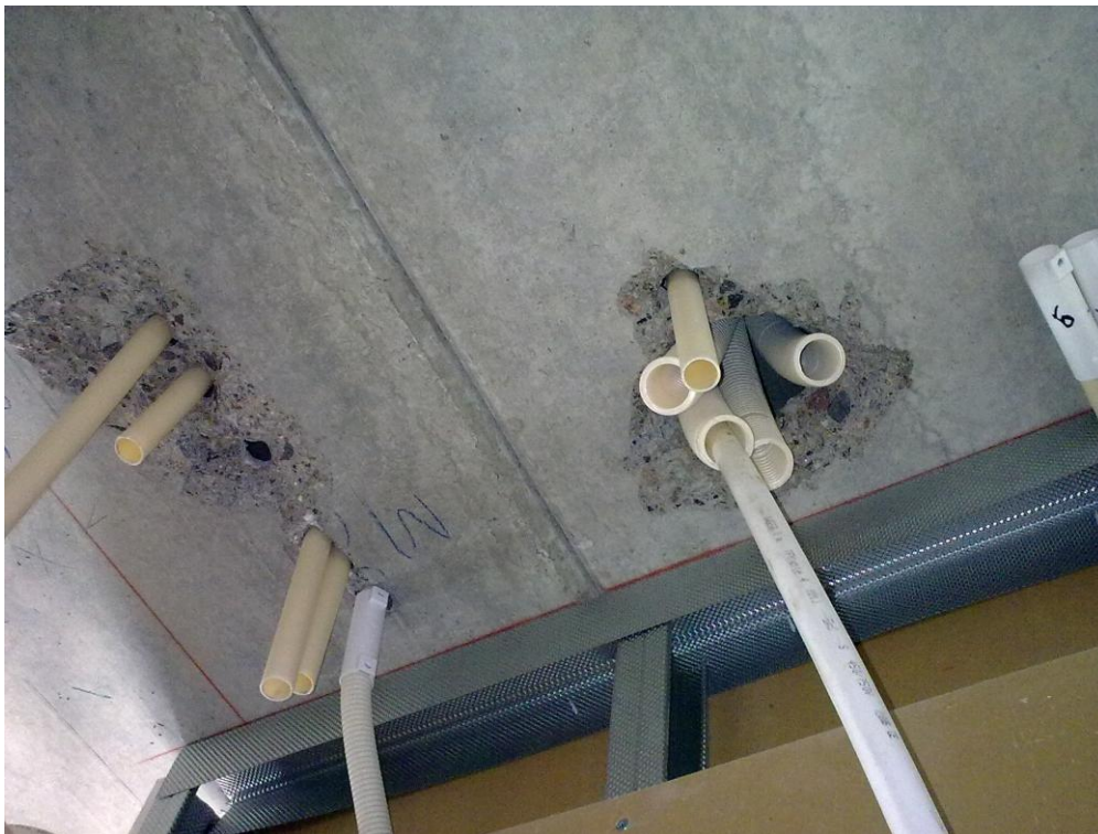
KUVA 9. Sähköläpiviennit ontelolaatassa.
