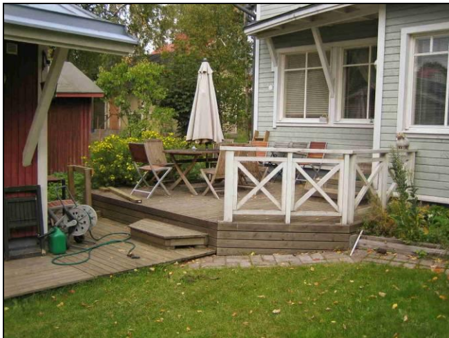
Kuvio 56. Päärakennuksen julkisivu takapihalle päin.
