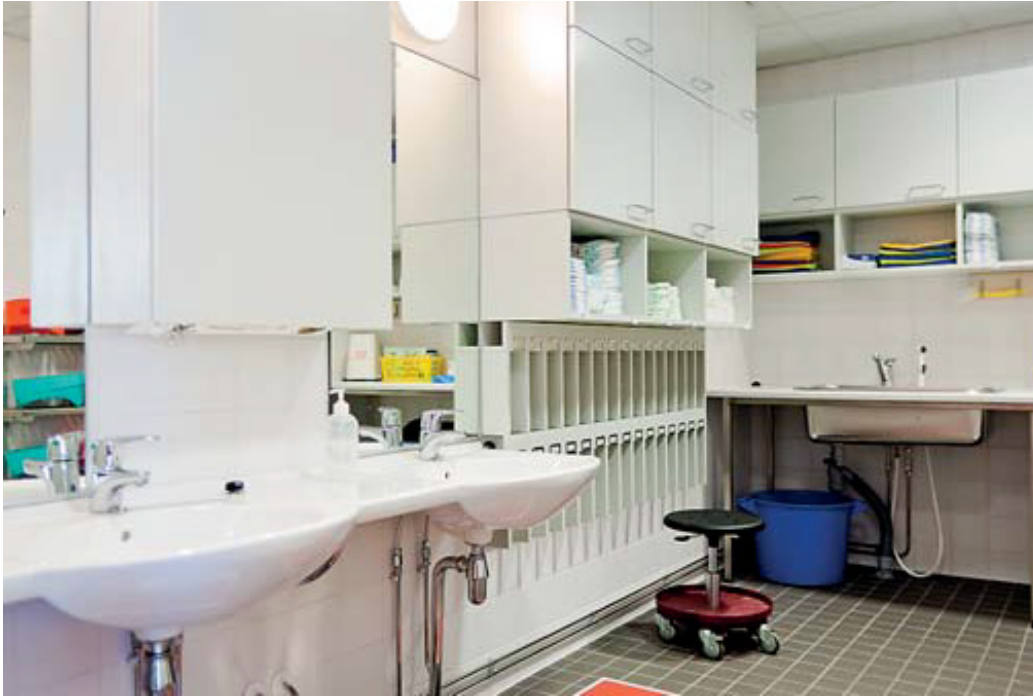
Kuva 9. Rakennustietosäätiö 2010. Päiväkoti Pajalahti, Helsinki. Pesuhuoneessa hoidetaan käsienpesun lisäksi usein pienten lasten vaipanvaihto. Allastasoja on oltava sekä lasten-, että aikuisten korkeudella.
