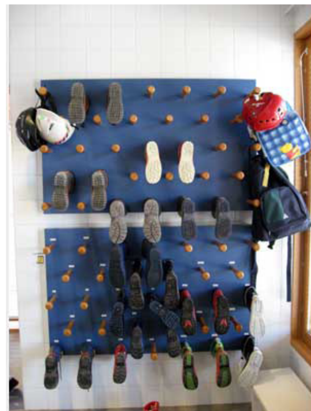
Kuva 11. Arkkitehtitoimisto Molino Oy. Puinen saapasseinä. Puinen kaluste on sijoitettu irti lattiapinnasta.
