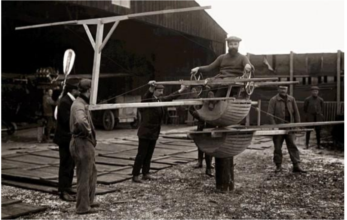
Kuva 1. Luultavasti maailman ensimmäinen lentosimulaattori, joka rakennettiin sotilaaksi opiskelevan pyynnöstä Mourmelonissa Ranskassa.
