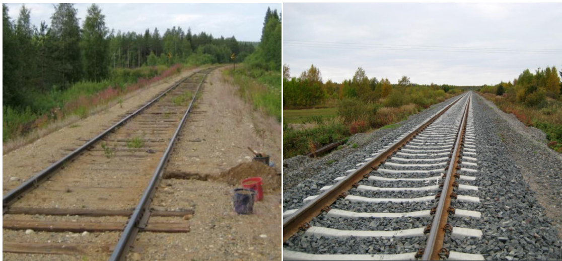
Kuva 6. Soraraiteen ja sepeliraiteen ero [5].
