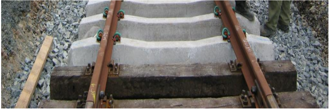
Kuva 2. Betonisia ratapölkkyjä vaihdetaan puisten tilalle [2].
