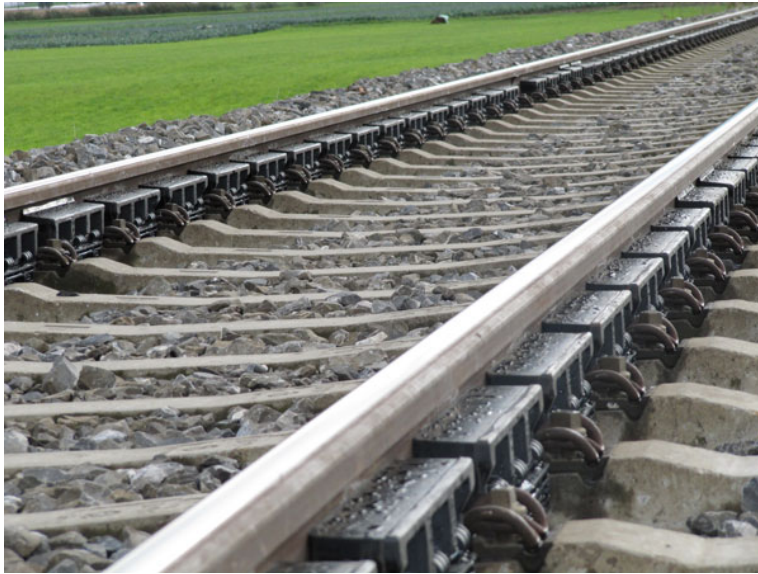
Kuva 8. Kiskoihin asennetut melunvaimentimet [7].
