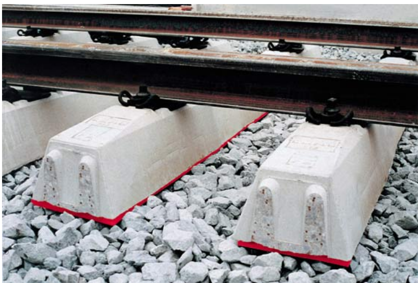
Kuva 9. Betonisten ratapölkkyjen pohjaan asennetut pohjaimet [8].
