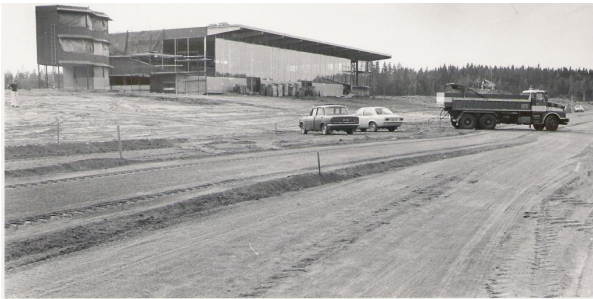
Rakennustyöt olivat loppuillaan keväällä 1980. RAIMO NAUMANEN
