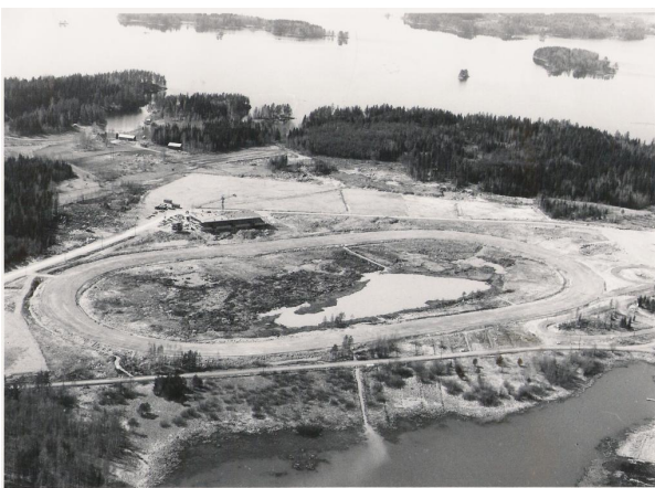
Sorsasalo valittiin uuden raviradan paikaksi. Ilmakuva Kuopion raviradan rakennustöistä Sorsasalossa. RAIMO NAUMANEN
