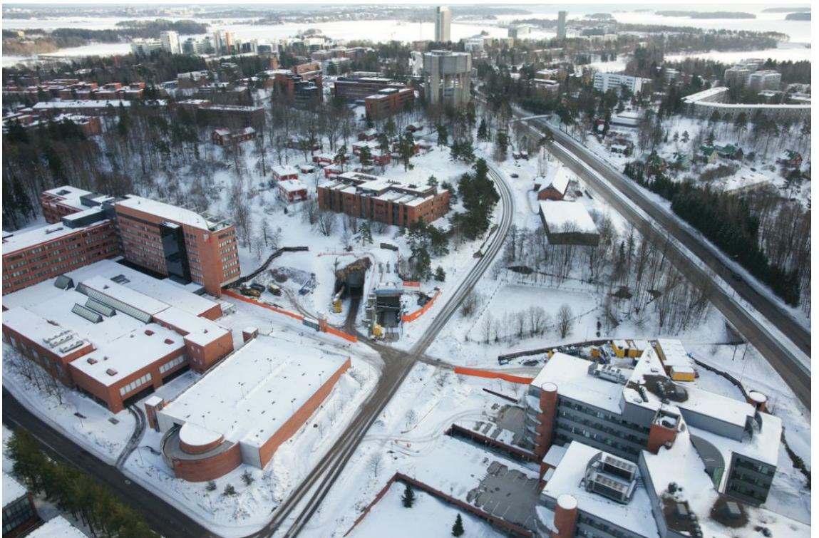
Kuvio 7. Otaniemen maanpäällinen työmaa-alue. Kuvassa keskellä sijaitsee Otaniemen tunnelin suuaukko. Tunnelin suuaukon oikealla puolella on VTT:n tutkimushallin suuaukko. Kuvassa näkyy myös kahden lähtöpisteen sijainti. Piste 5008 sijaitsee kuvassa ylhäällä keskellä olevan vesitornin päällä ja piste 5005 kuvassa oikealla olevan Kehä 1:n sillan päällä. (Länsimetro Oy)
