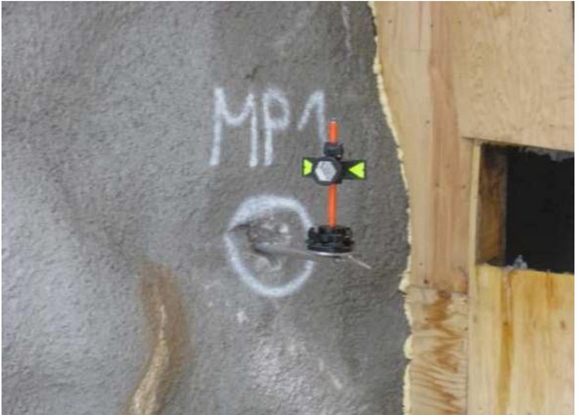
Kuvio 8. Putkipiste, jonka päällä pakkokeskistysalusta sekä prisma. (Siven 2010)
