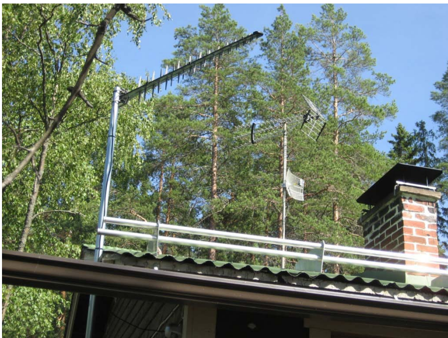
KUVA 11. WLAN-antenni etualalla, 3G-antenni takana (Kuva: Lassi Rautiainen 2011)
