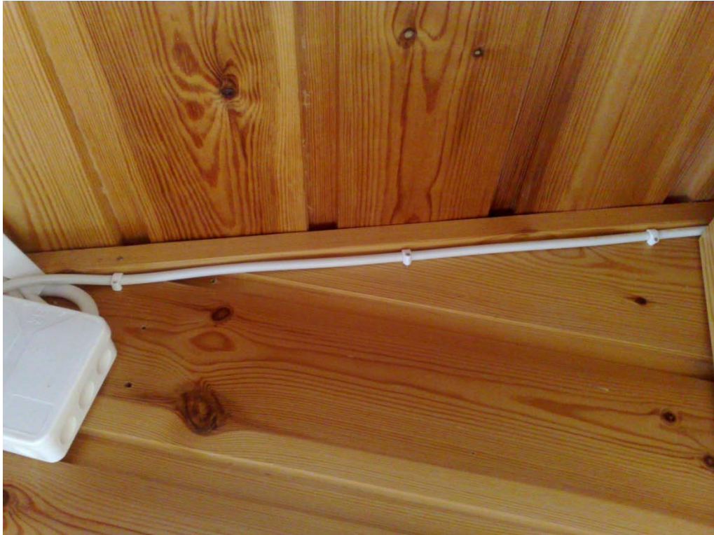
KUVA 9. Kaapelin kiinnitys naulakiinnikkeillä (Kuva: Lassi Rautiainen 2012)
