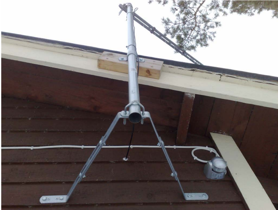
KUVA 10. WLAN-antenni asennettuna (Kuva: Lassi Rautiainen 2011)
