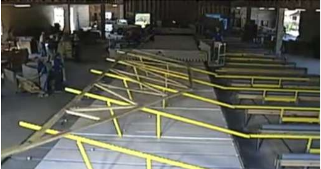
KUVIO 23. Valmis kattoristikko siirretty eteenpäin nostimien avulla (Alpine Equipments 2008 - 2010)
