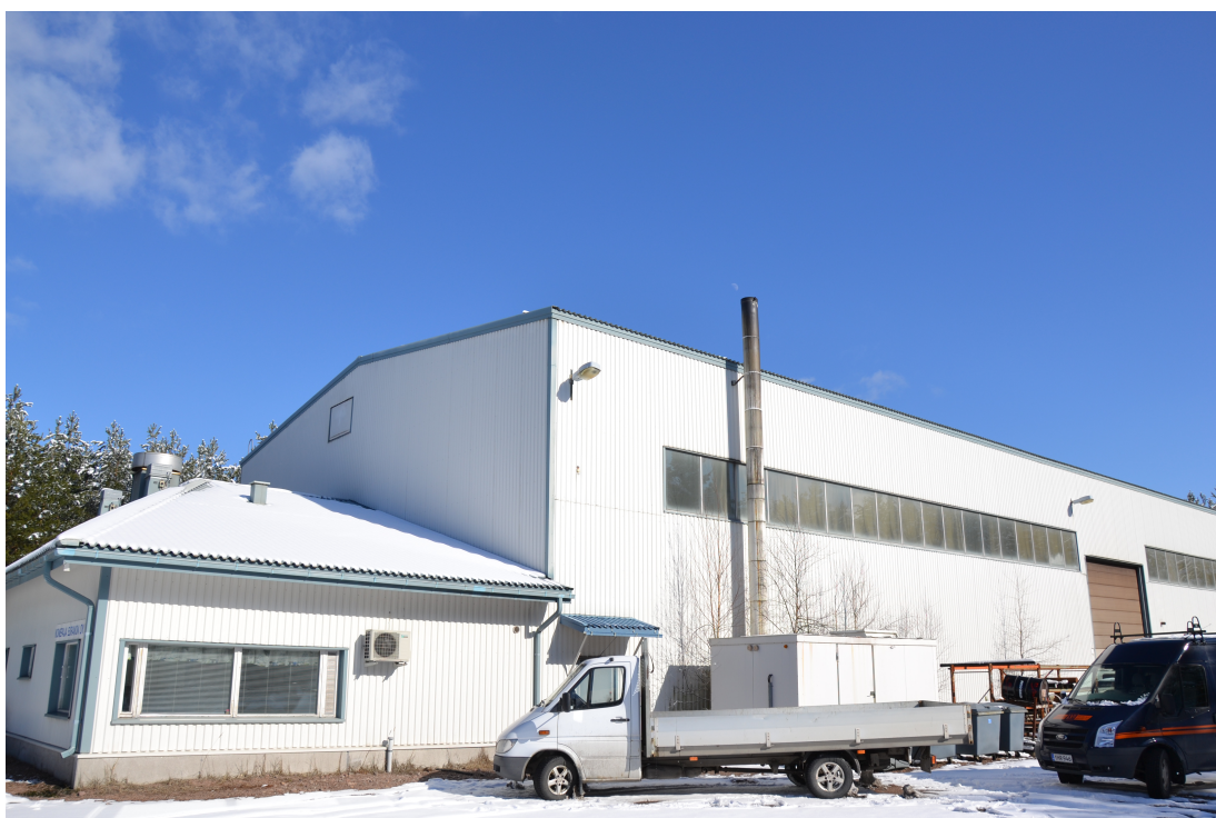
Kuva 1.1 Eurakon Oy:n hallirakennus
