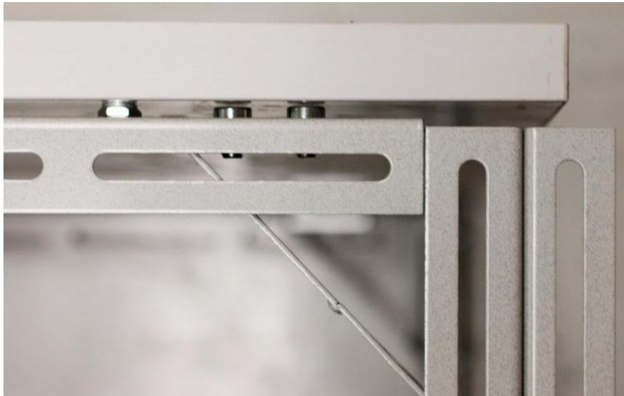
Kuva 48. Yksityiskohta pöytälevyn kiinnityksestä
