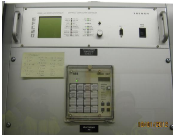
Kuva 30 Maasulkuvirran kompensoinnin säätäjä ja hälytyskeskus
