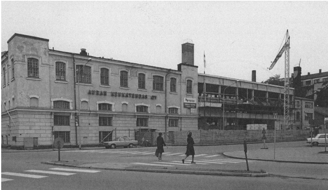
KUVA 4. Laajennusosa rakennusvaiheessa Auran Kenkätehtaan aikana 1970-luvulla (Mäntylä 2009)
