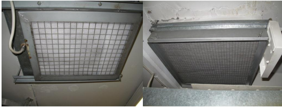
Kuvat 96 ja 97. Muuntamon iv-aukot
