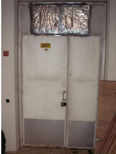
Kuva 89. Sisäänkäynti ja poistoilma-aukko
