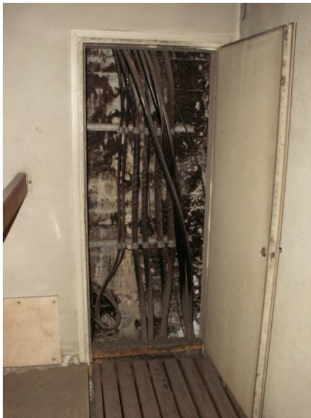
Kuva 40. Ovi perusmuurin ja verhomuurauksen välitilaan
