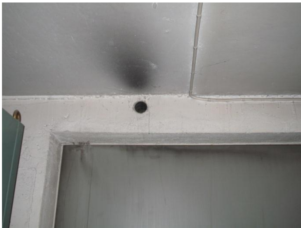
Kuva 70. Oven yläpuolinen aukko
