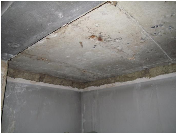
Kuva 55. Muuntajan yläpuolinen rakenne
