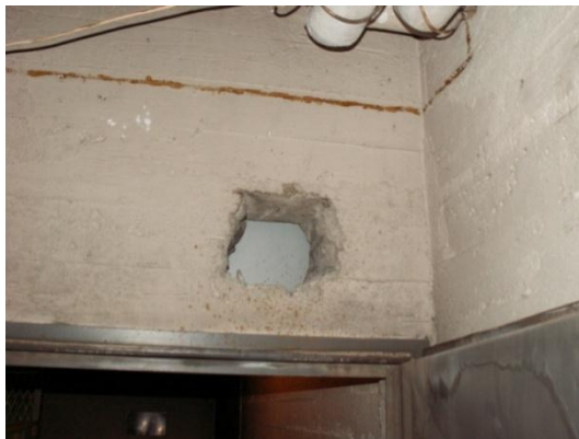
Kuva 45. Oven yläpuolinen aukko
