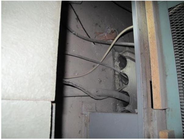
Kuva 67. Maahan menevät kaapelit
