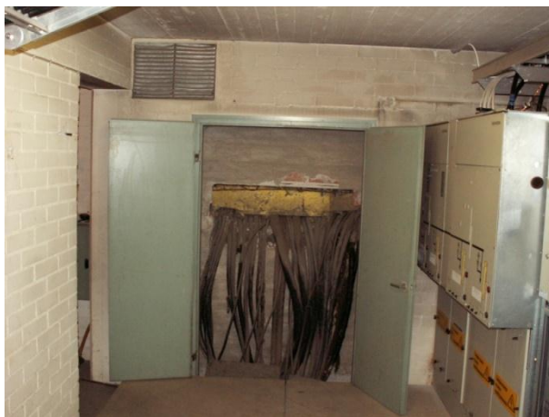
Kuva 9. Tuloilman otto ja kaapelilähdöt maahan
