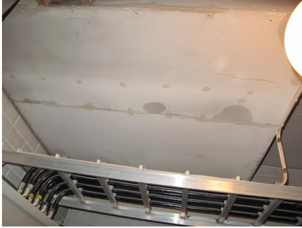
Kuva 48. Muuntamotilassa oleva ylimääräinen iv-kanava
