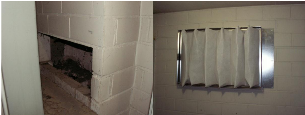
Kuvat 33 ja 34. Muuntamon iv-aukot
