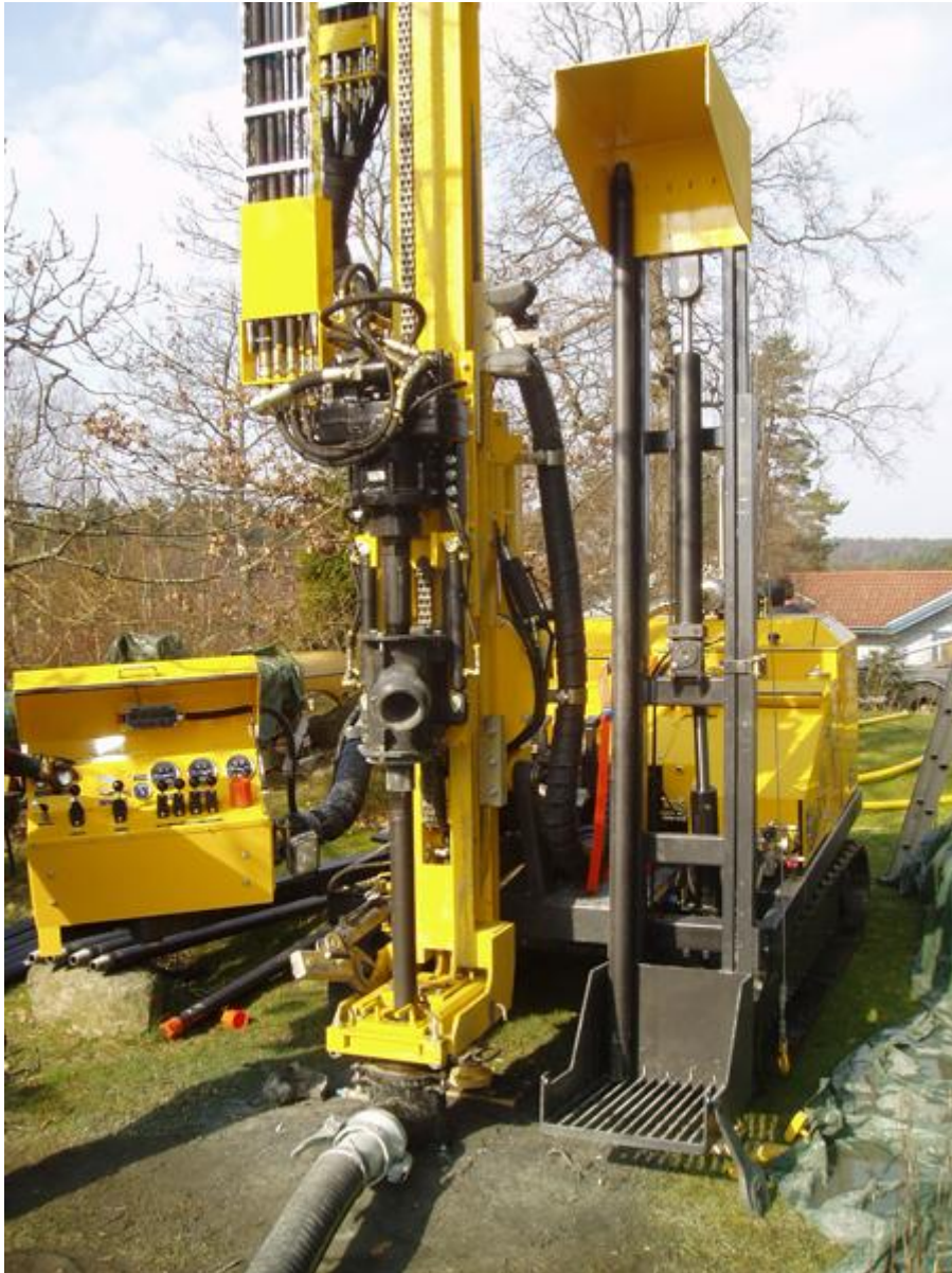
Kuva 6. Lämpökaivon poraus meneillään. (14.)
