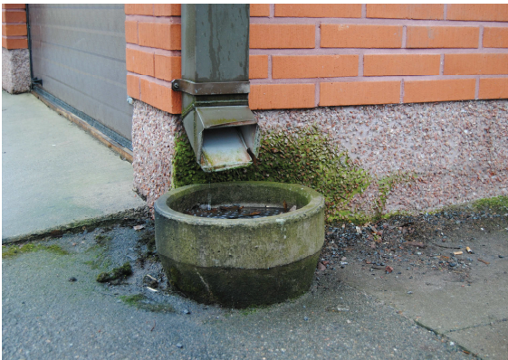
Betoniset sadevesikaivot
