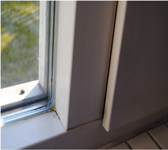
Tuuletusikkunan tiivistys
