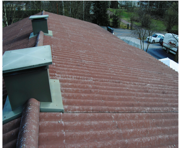
Talo B:n vesikatto
