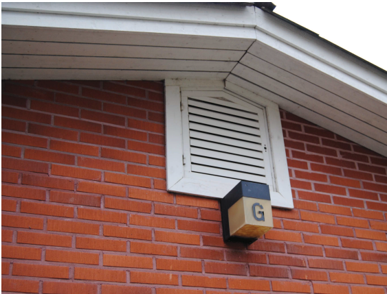
Ilmanvaihtosäleikkönä toimiva luukku
