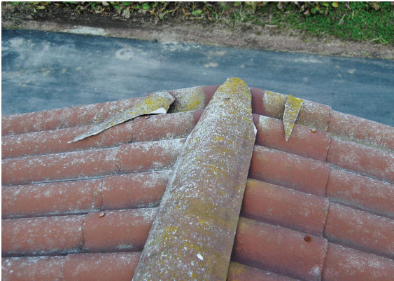
Halkeamia ja irronneita paloja harjatiilissä, sekä sammalkasvustoa
