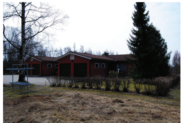
Talo B julkisivu pohjoiseen
