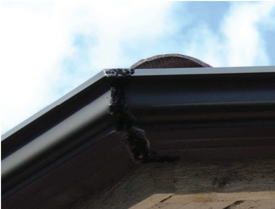
Kourukulman bitumitiivistys
