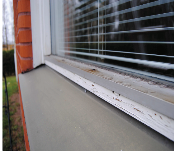
Ikkunan alapuite ja alumiinilista
