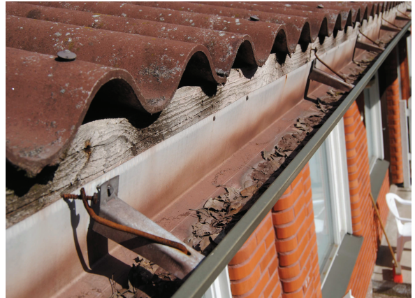
Kourujen kiinnitys
