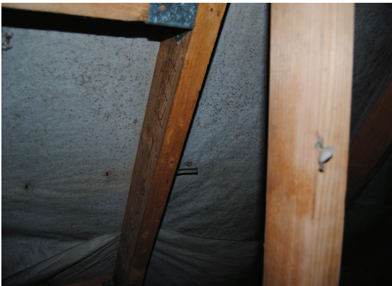
Hometta aluskatteen alapinnassa, talo B
