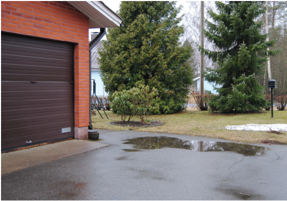
Talo B, pihassa vesi lammikoituu
