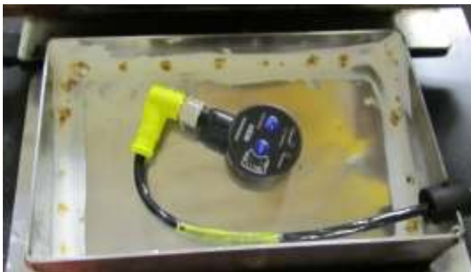
Kuva 25. Ultraäänianturi paikalleen asennettuna
