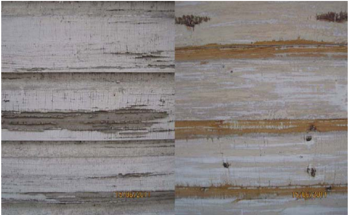
KUVA 25. Julkisivu ennen ja jälkeen maalinpoiston.
