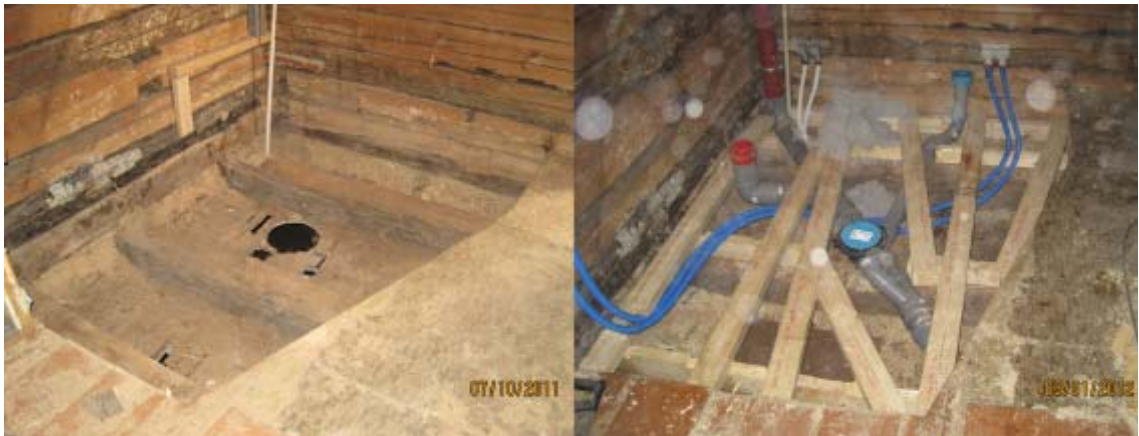
KUVA 30. Kylpyhuoneen rakentamisen ensimmäiset vaiheet.
