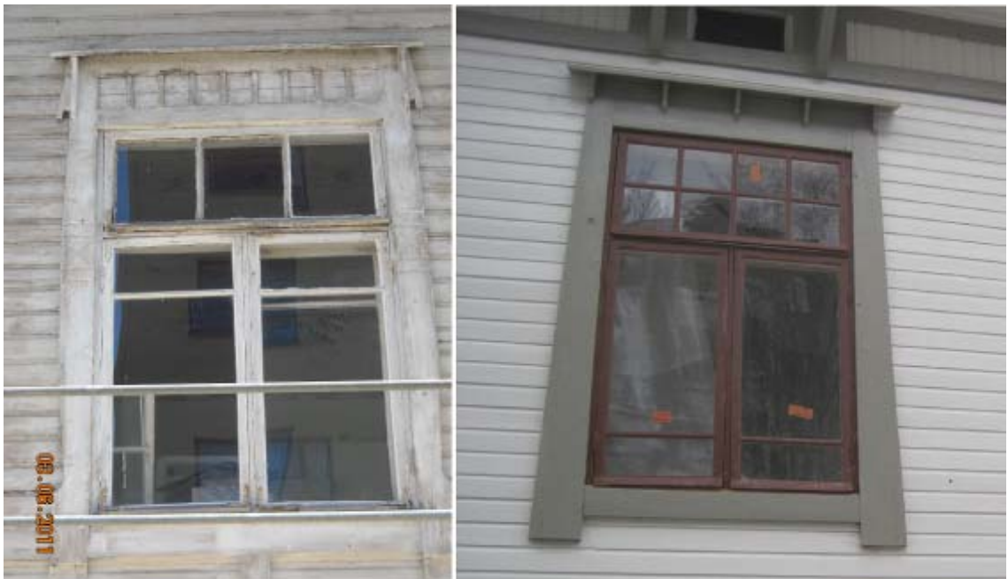
KUVA 27. Korttelin yleisimmät ikkunatyypit kuvattuna työmaan alussa ja lopussa.
