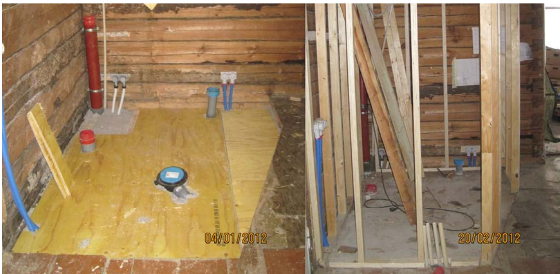
KUVA 31. Kylpyhuoneen rakentamisen seuraavat vaiheet.
