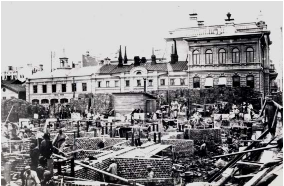
KUVA 2. Commercen talo rakenteilla keskustorin laidalla. Taustalla näkyvistä rakennuksista ainoastaan raatihuone on säilynyt nykypäivään. (Tampere-Seuran kuva-arkisto)
