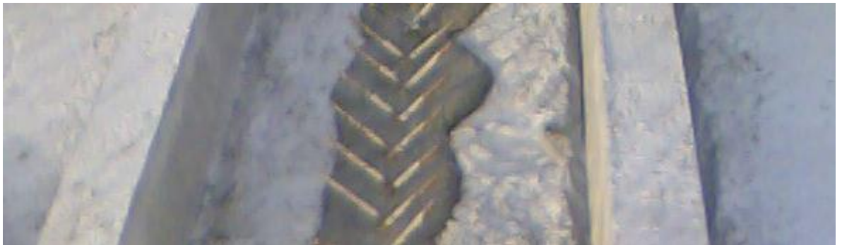
Kuva 5. Kuorilaatan sivusauman rauditus ja valu. (Kuva: Mika Kokkonen. Työmaakuva Lappeenrannasta 2006.)
