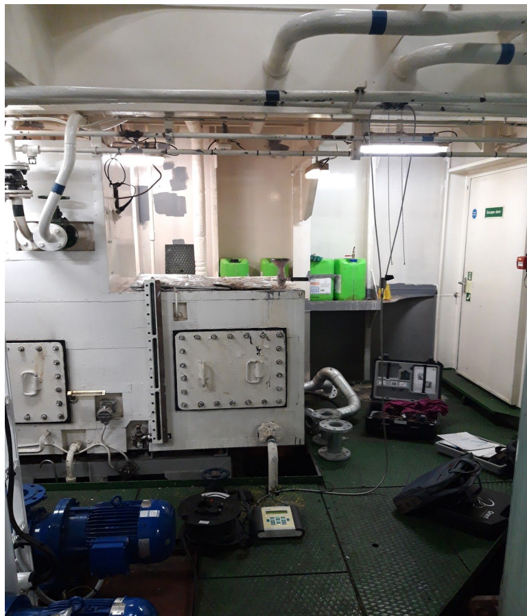
Figur 4. Pågående mätningar i pannrummet.
