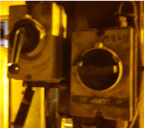
KUVA 23. Kuulamyllyn syöttöruuvien turvakatkaisijat.
