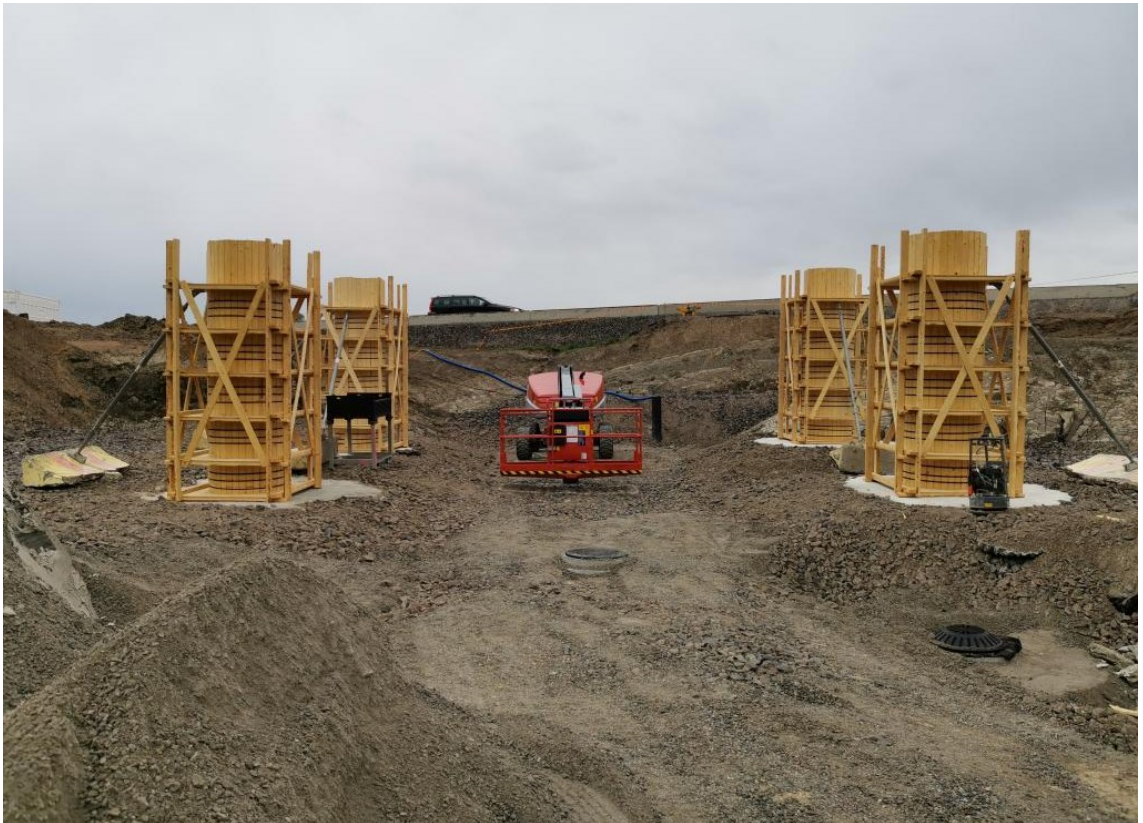
Kuvio 20. Pilarimuotit asennettuina sekä tuettuina vinotuilla. (Väylä, Mt 132 Klaukkalan ohikulkutie.)
