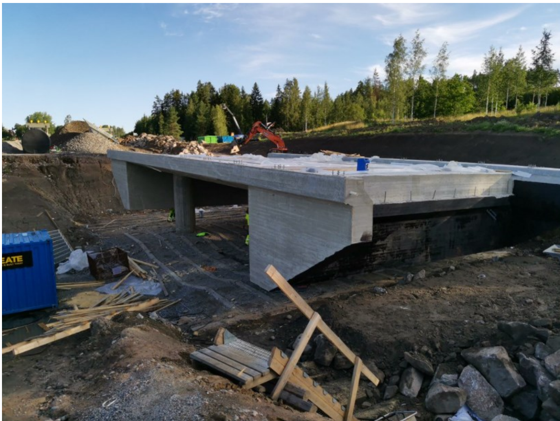
Kuvio 29. Silta valun ja muotin purkamisen jälkeen. (Väylä, Mt 132 Klaukkalan ohikulkutie.)
