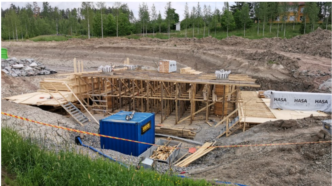
Kuvio 25. Niskojen, koolauksen sekä muottilaudan asennusta telineeseen. (Väylä, Mt 132 Klaukkalan ohikulkutie.)
