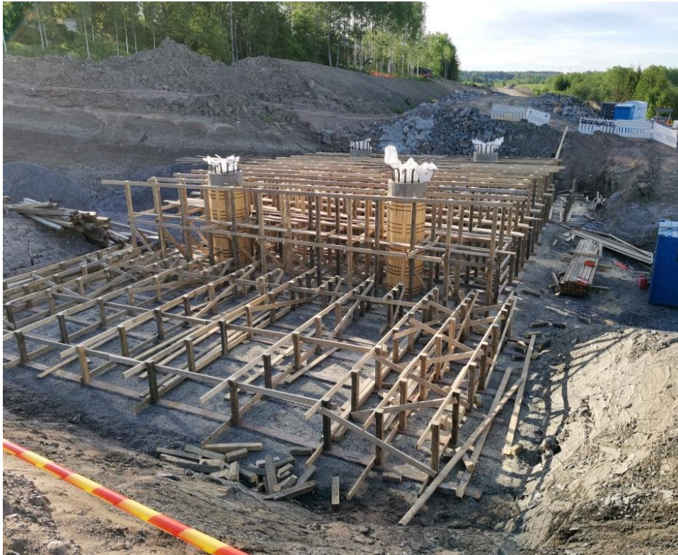
Kuvio 22. Telineolpukset sekä vaaka- ja vinositeet asennettuina. (Väylä, Mt 132 Klaukkalan ohikulkutie.)
