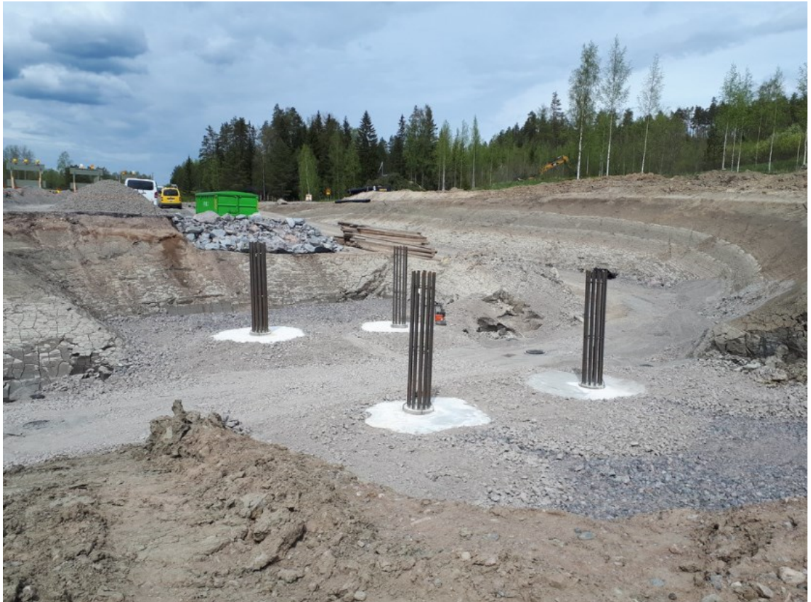
Kuvio 19. Paalut katkaisun, teräskehikon asentamisen sekä valun jälkeen. (Väylä, Mt 132 Klaukkalan ohikulkutie.)
