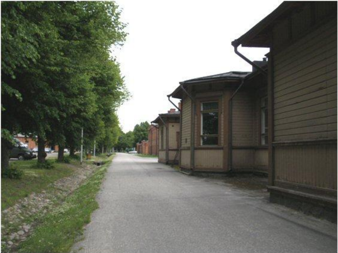
Sotilaskodin pohjoisjulkisivu ennen rakennusurakan alkua.
