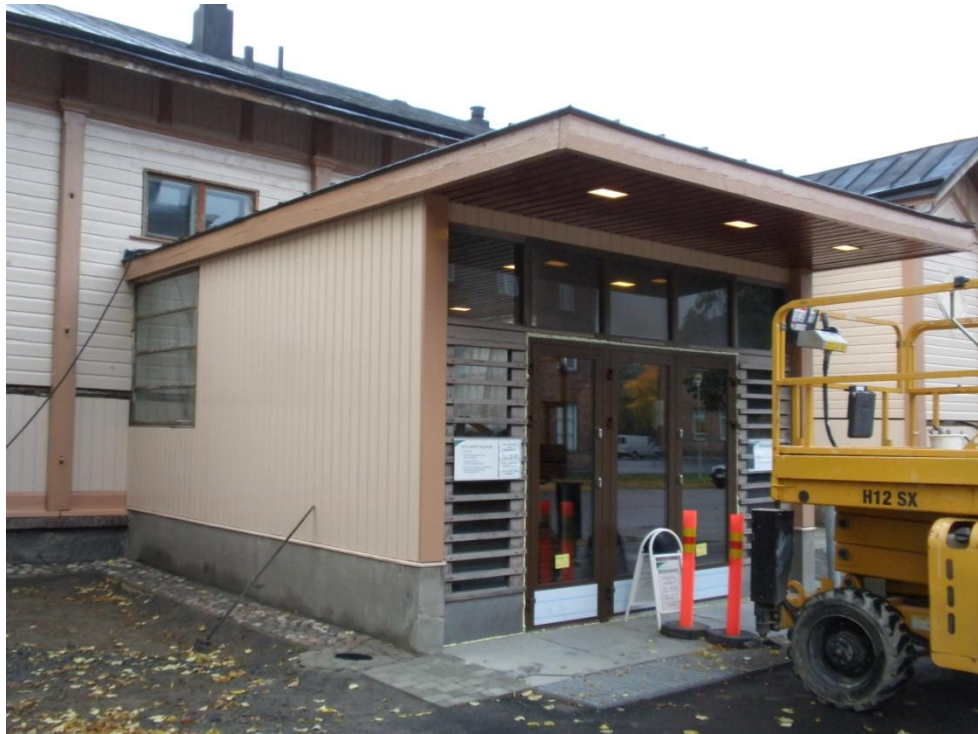
Kuva 15. Sotilaskodin 1950-luvulla rakennettu tuulikaappi. Keskelle on jo vaihdettu uudet alumiiniset ulko-ovet, reunoilla olevat kiinteät ikkunat koristerimoineen odottavat vielä maalausta.
