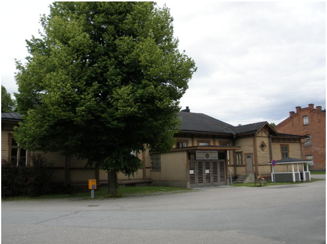
Sotilaskodin eteläjulkisivu ennen rakennusurakan alkua.
