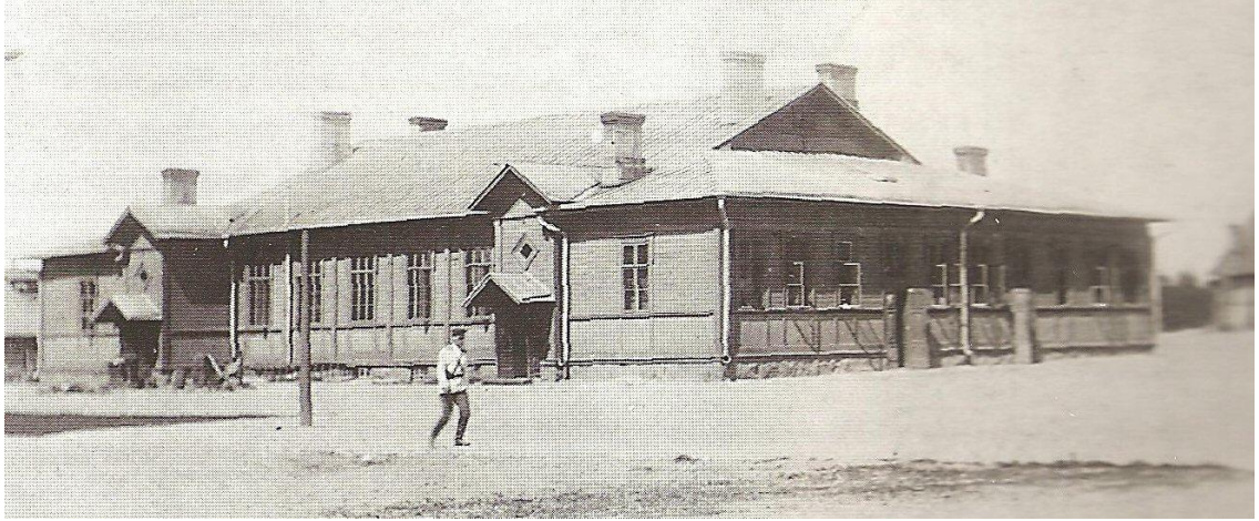
Kuva 16. Ruokalarakennus alkuperäisessä asussaan (17, s. 80)
