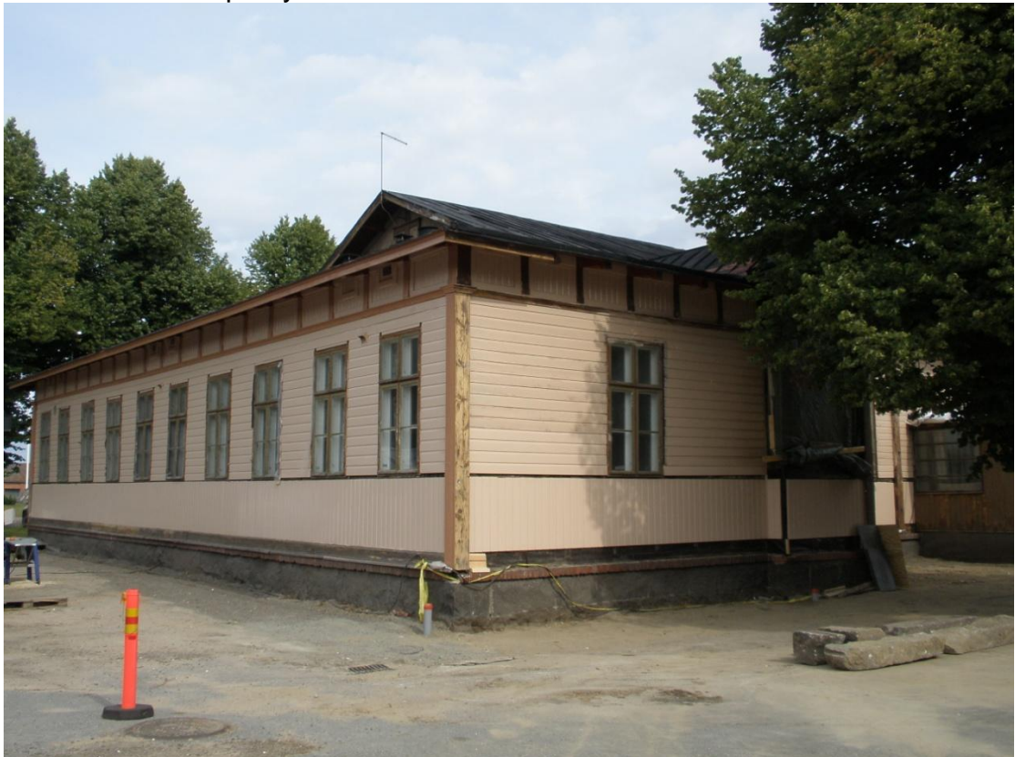
Sotilaskodin länsipääty maalaustyön loppuvaiheessa.
