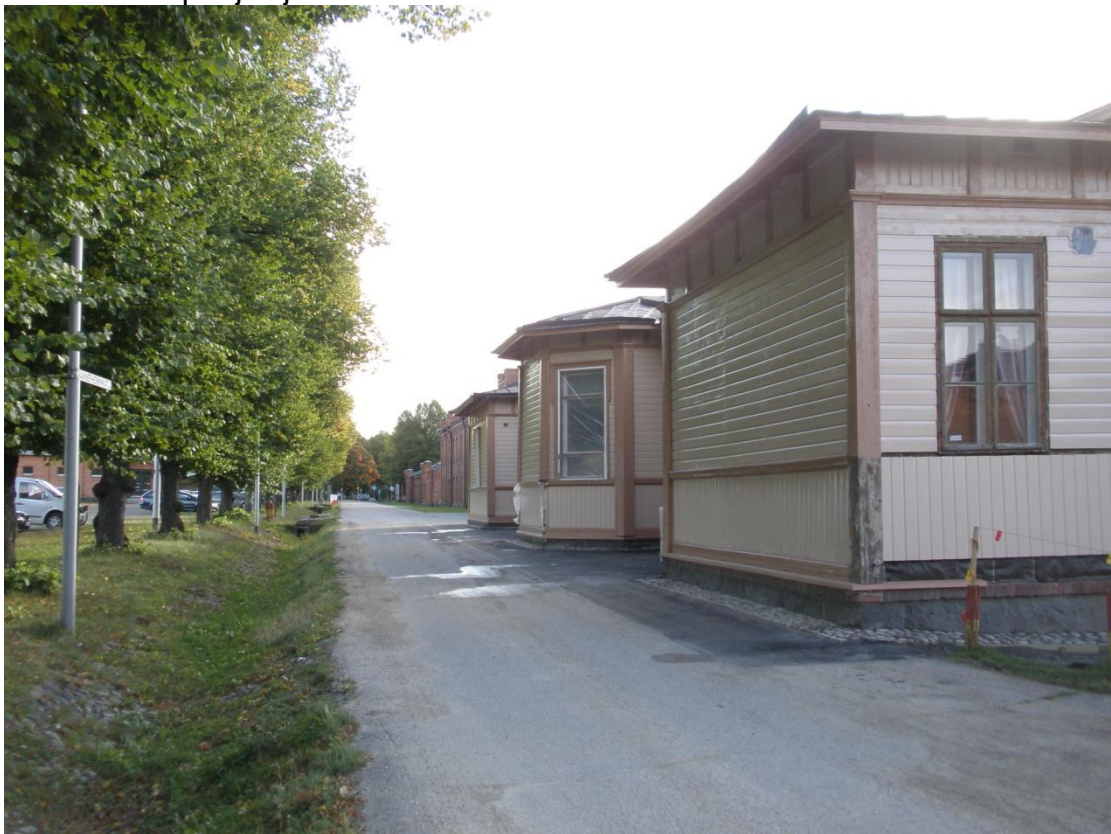
Sotilaskodin pohjoisjulkisivu maalaustyön loppuvaiheessa.
