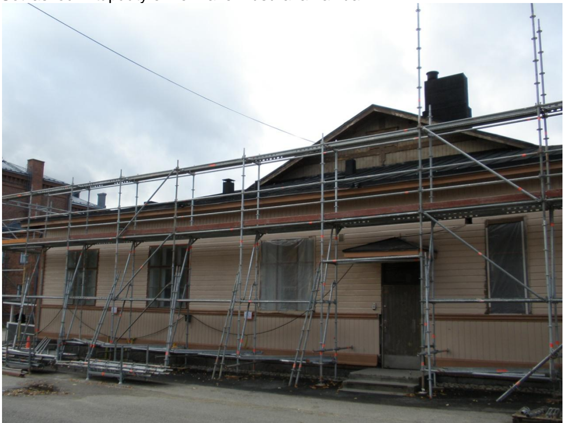
Sotilaskodin itäpääty sääsuojan telinetyön alkuvaiheessa.
