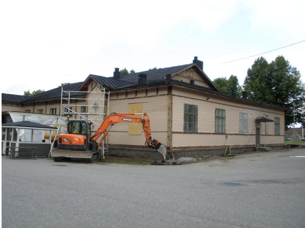
Kuva 19: Rakennuksen etelä- ja itäfasadit maalausurakan keskivaiheilla. Itäpäädyn sadevesiviemärien asennus on juuri valmistunut.
