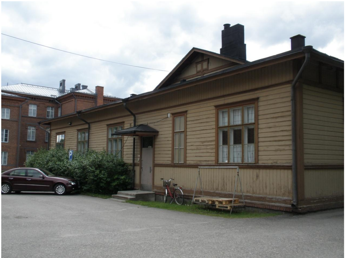
Sotilaskodin itäpääty ennen rakennusurakan alkua.
