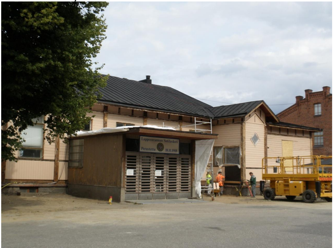
Sotilaskodin eteläjulkisivu maalaustyön puolivälissä.
