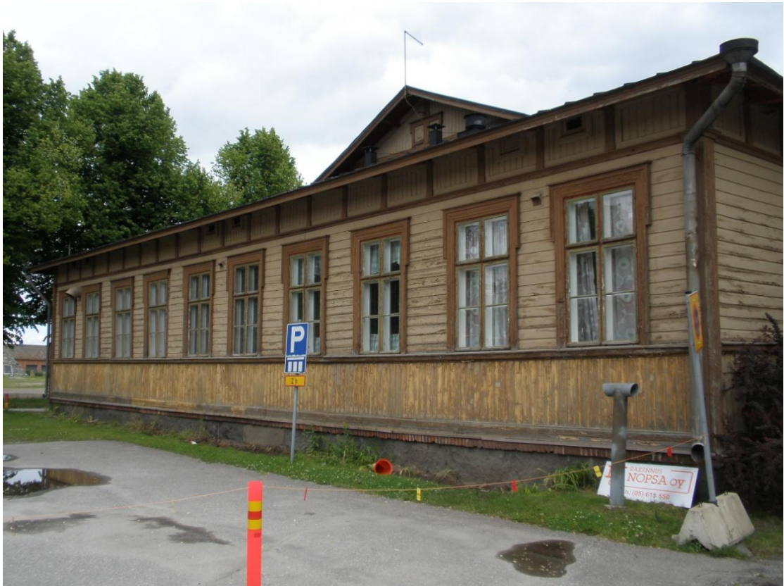
Sotilaskodin länsipääty ennen rakennusurakan alkua.
