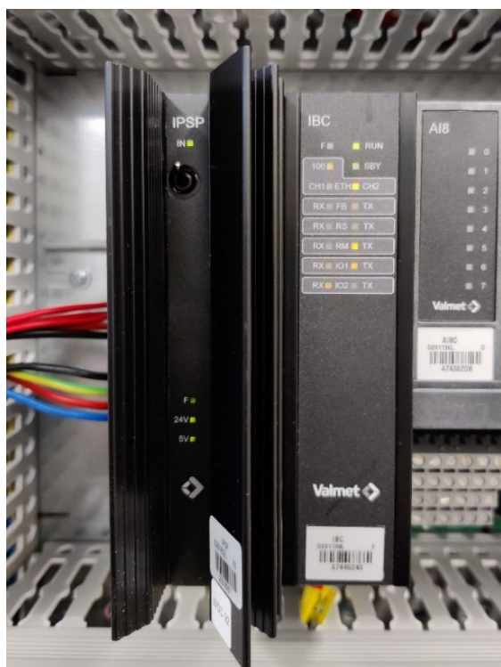
Kuva 17. IPSP-tehonlähde & IBC-väyläohjain (Paavilainen 2021)
