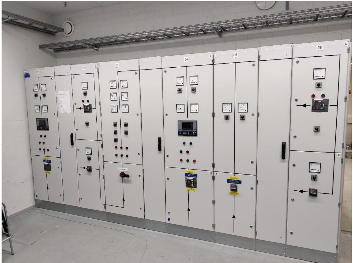
Kuva 5. Sähköpäätaulu (Paavilainen 2021)
