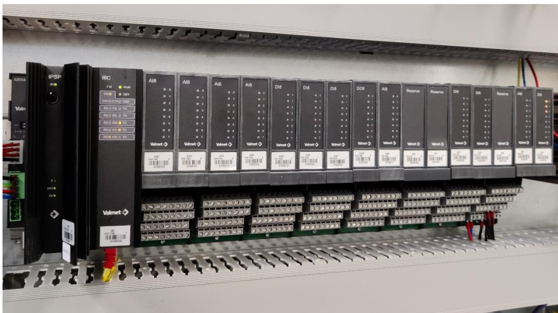
Kuva 16. ACN I/O-yksikkö (Paavilainen 2021)
