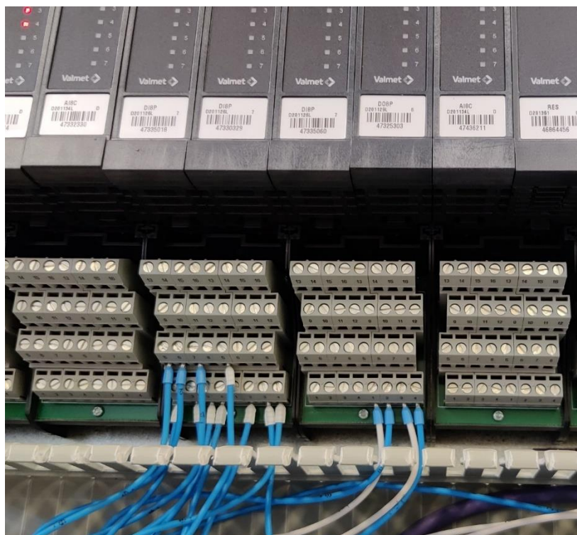
Kuva 19. Kaapeliliittimet kenttäkaapelin kaapelipareille (Paavilainen 2021)
