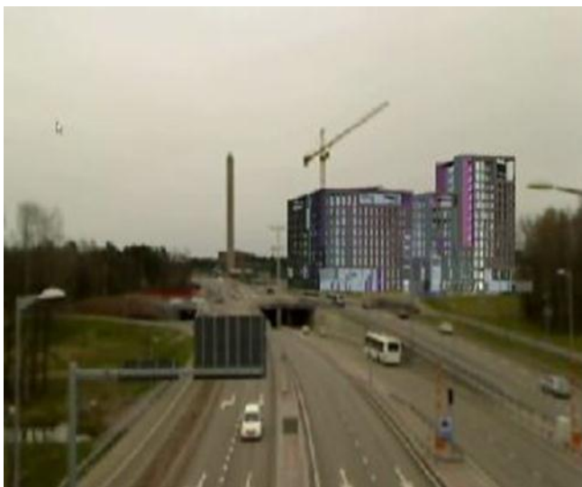
Kuva 7. Skanskan uusi Suomen pääkonttori katsottuna Augmented Reality -tekniikalla [11].
