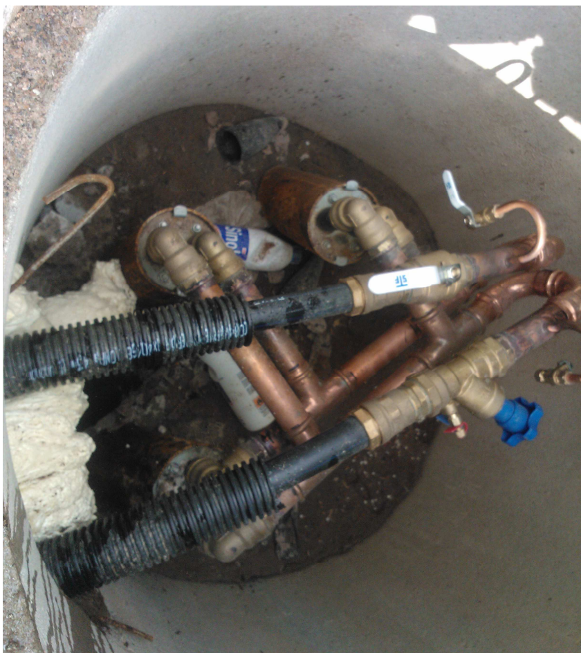
Kuva 7 Lämmönkeruureikien kaivo, omakuva, 2012
