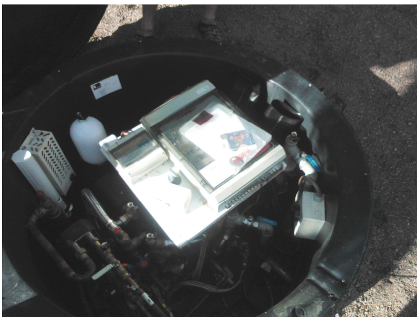
Kuva 8 Maalämpökeskus, omakuva, 2012
